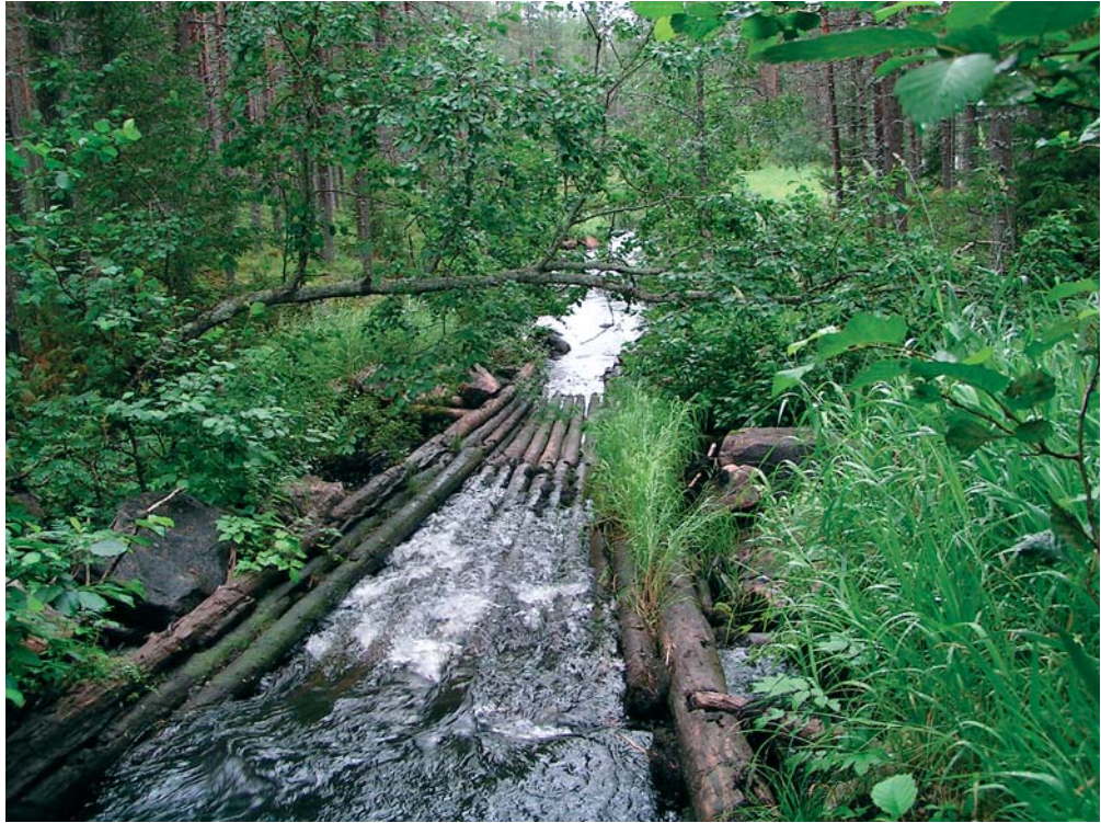
Kuva 22. Ränni/uittoruuhi toimi kalojen vaellusesteenä Outojoella. Kuva Marko Kangas.
