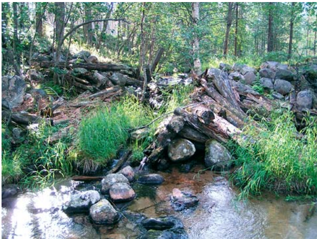
Kuvat 16 ja 17. Vasemmalla Kallio-ojan sortunut pato/tammi ennen kunnostustyötä ja oikealla sama kohde kunnostuksen jälkeen. Kuvat Marko Kangas.
