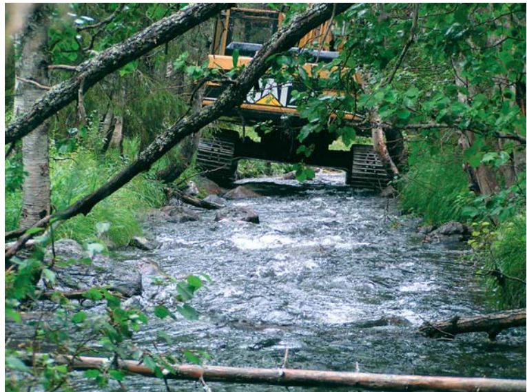
Kuva 9. Joen pohja ja rantakasvillisuus säilyi vahingoittumattomana telojen kulkiessa kivien päällä. Kuva Marko Kangas.
