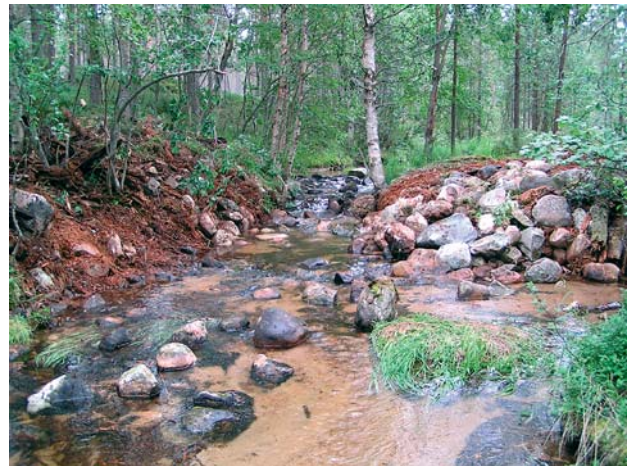
Kuvat 16 ja 17. Vasemmalla Kallio-ojan sortunut pato/tammi ennen kunnostustyötä ja oikealla sama kohde kunnostuksen jälkeen. Kuvat Marko Kangas.
