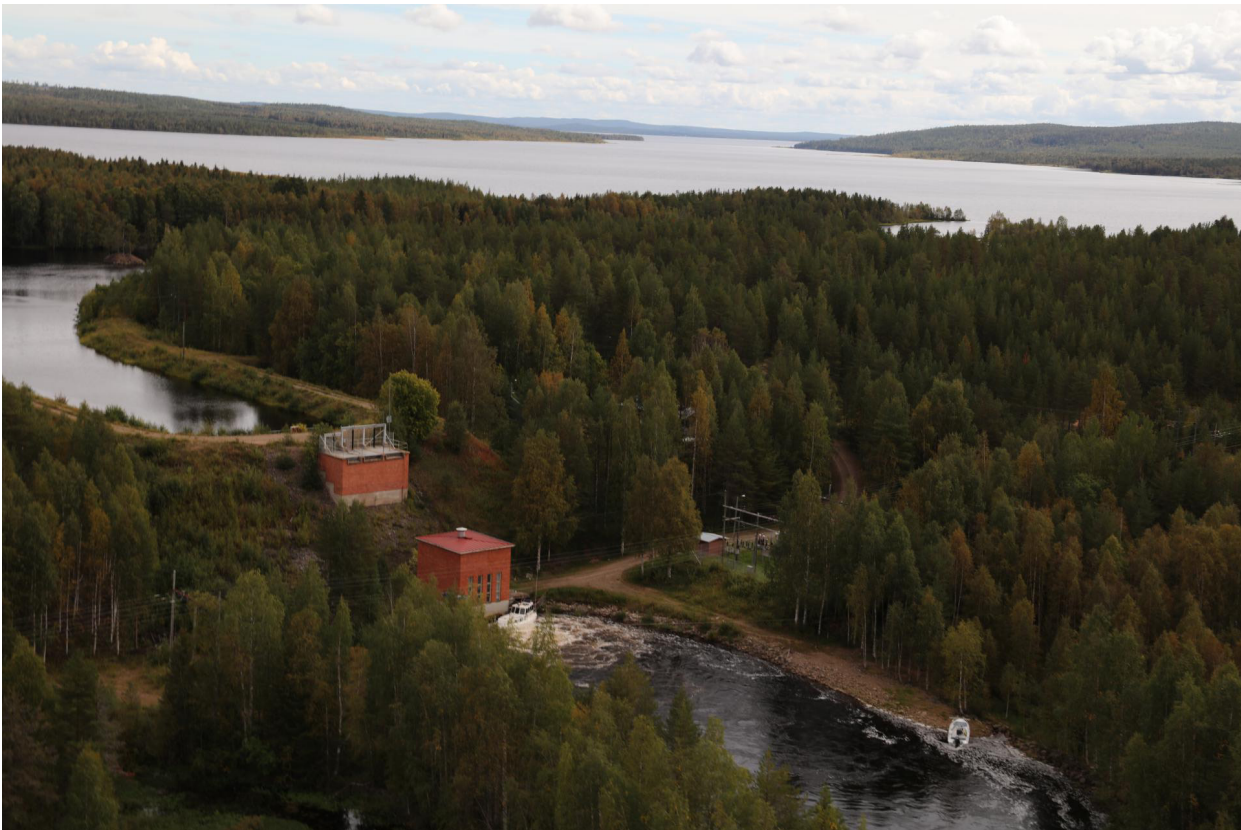
Kuva 22. Kaaranneskosken voimalaitos. © TLV Oy
