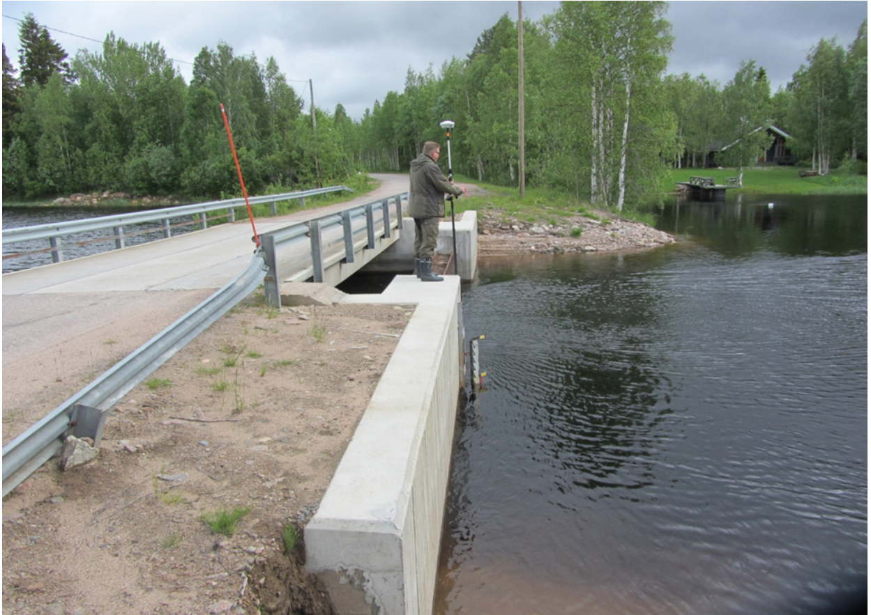
Kuva 4. Mittaustöitä Kaaranneskosken sillalla. © A. Honka
