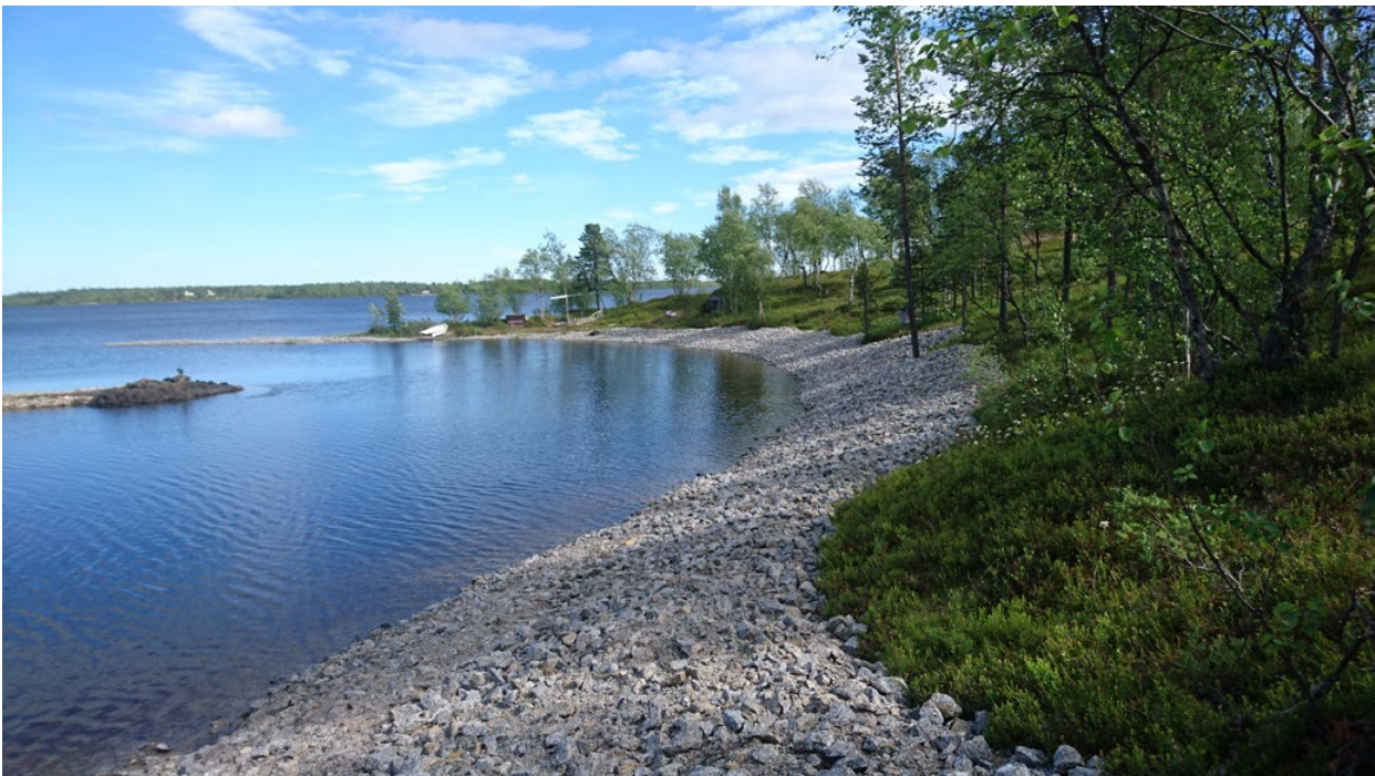
Kuva 17. Inarijärven Partakossa tehty rannan eroosiosuojaus (kuva: Lapin ELY-keskus).
