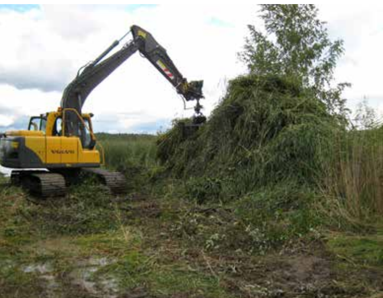
Leikattu ruokomassa nostettiin vedestä maalle ja edelleen rannalta kuorma-autojen lavoille kaivinkoneen sokerijuurikaskahmarilla. Kuva: Marjo Perkonaja
