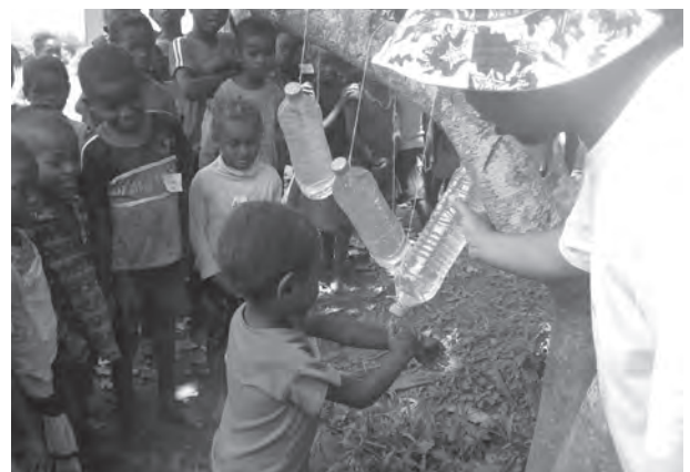
Fig. 6: Installation d'un système de lave main à l'école.
