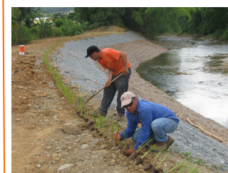
Inicio de la siembra en la parte superior del talud.
