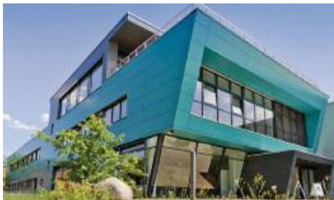
Das markante Firmengebäude in Berlin-Mitte am Humboldthain ist die Heimat des Berliner Druckzentrums.
