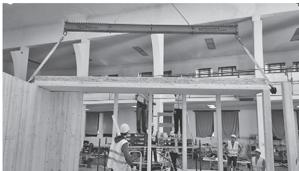
Slika 6. Postavljanje stropne ploče u Kineskom paviljonu (Foto: tim UniZG, 2014.)
