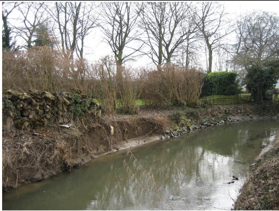
(Blick bachabwärts) Angerprofil in Höhe der Gärten Wohnbebauung Schlossallee
