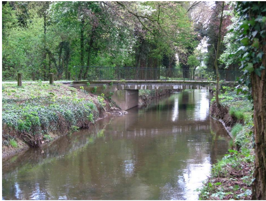
(Blick bachaufwärts) Brücke Heltorfer Schlossallee
