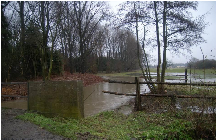
(Blick bachaufwärts): Bereich Wirtschaftswegebrücke am Haus Bilkrath - Hochwasser-situation Januar 2011
