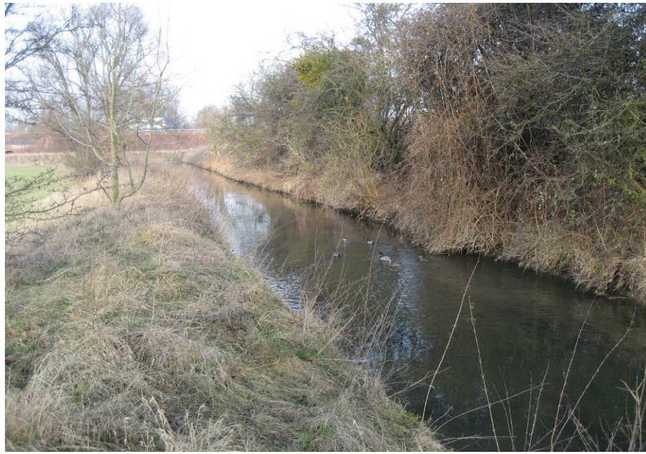
(Blick bachabwärts) Ausbauprofil mit Deich am rechten Ufer
