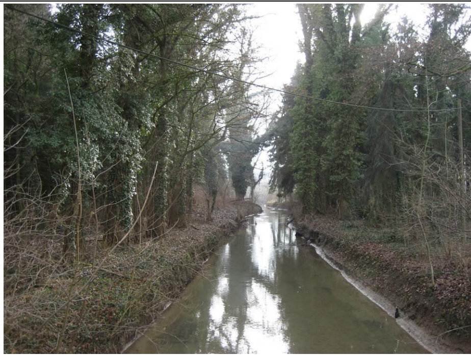
(Blick bachaufwärts) relativ gestreckte Linienführung der Anger im Bereich Brücke Heltorfer Schlossallee mit begleitender Hybridpappelreihe und Fichtenbeständen
