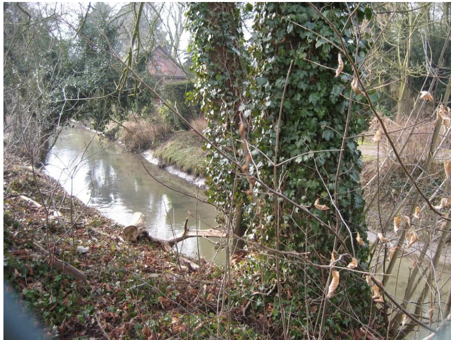
(Blick bachabwärts) Angerprofil unmittelbar oberhalb Wehranlage
