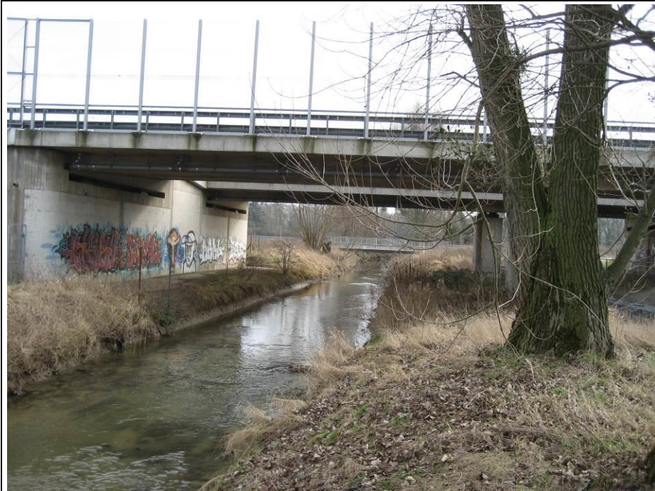
(Blick bachaufwärts) Brückenbauwerke B 8n und paralleler Wirtschaftsweg (Verbindung Verloher Kirchweg-Koenenkampweg Richtung Klein-Winkelhausen)
