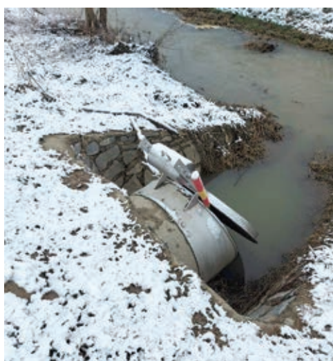
Foto: Nigrad, k. p., d. o. o. (zlonamerna preusmeritev vodotoka v kanalizacijski sistem)
