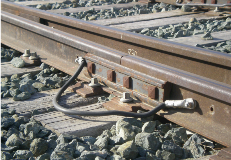
Figura 2. Aseguramiento de la unión eléctrica de los carriles a través de la brida.
