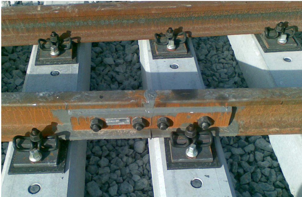
Fig. 7.- Detalle de montaje de junta aislante
