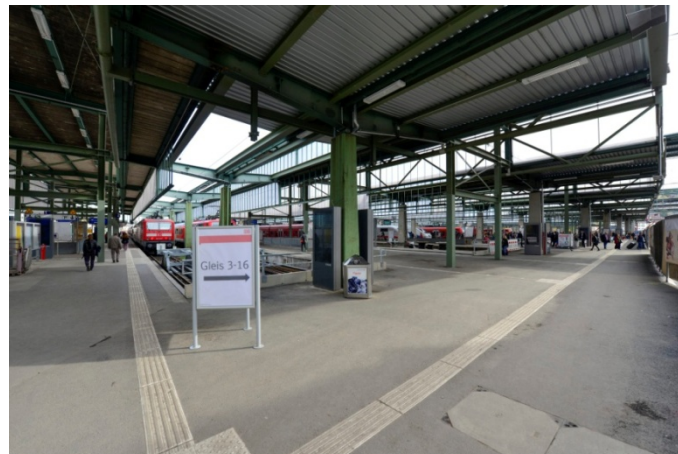
Abb. 31: Neuer Querbahnsteig Stuttgart Hbf, Quelle: DB Projektbau
