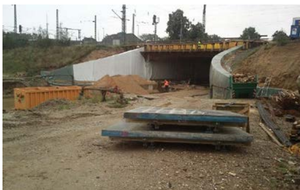
Abb. 16: Bauwerk in Endlage
