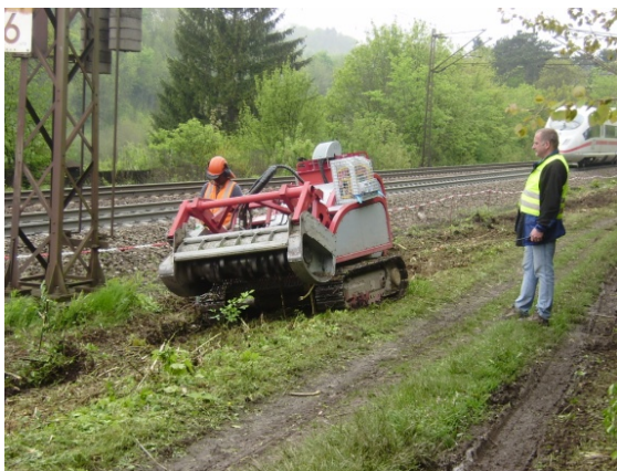
Abb. 37 Einsatz eines LUF-Bushcat™ mit aufgesetztem, mobilen Funkwarngerber Quelle: DB Fahrwegdienste/ Olaf Braunert
