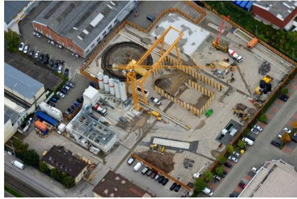
Abb. 33: Zwischenangriff Ulmer Straße PFA 1.6a Quelle: DB Projektbau
