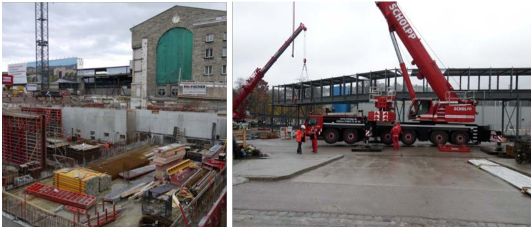
Abb. 31: Bau Technikgebäude Frühjahr 2013, Quelle: Inge BÜ S21 Tiefbahnhof und Bau Schlossgartensteg, Herbst 2013, Quelle: Züblin
