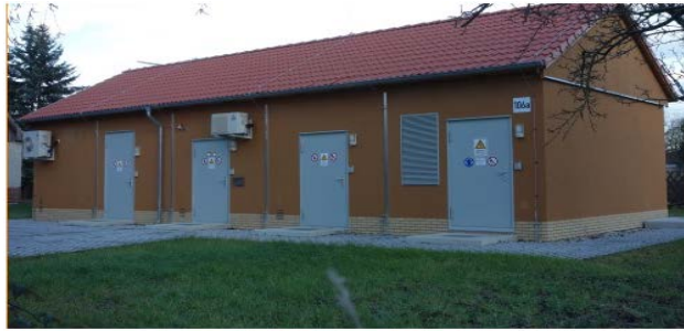
Abb. 5: Stellrechnergebäude in Medewitz, Quelle: DB Netz AG
