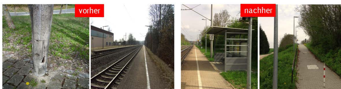
Abb. 80: Erneuerung Beleuchtungsanlagen (Ellingen)
