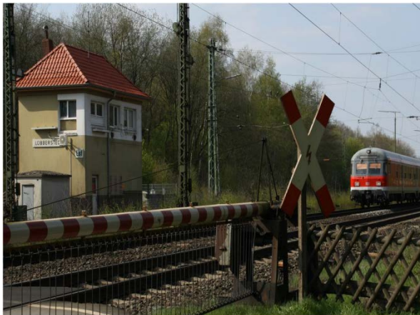
Abb. 3: Altstellwerk in Lübberstedt (links)
