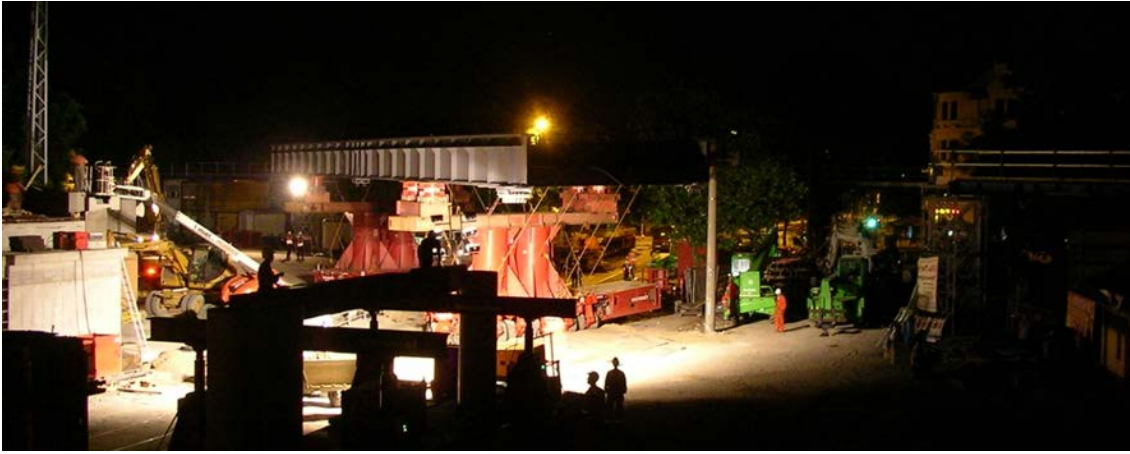
Abb. 10: Verschub des Stahlrogüberbaus mittels Hubwagen, Quellen: DB Projektbau GmbH
