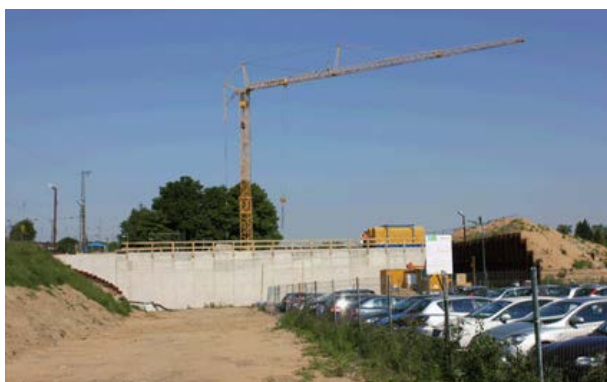
Abb. 15: Rahmenbauwerk vor dem Einschub
