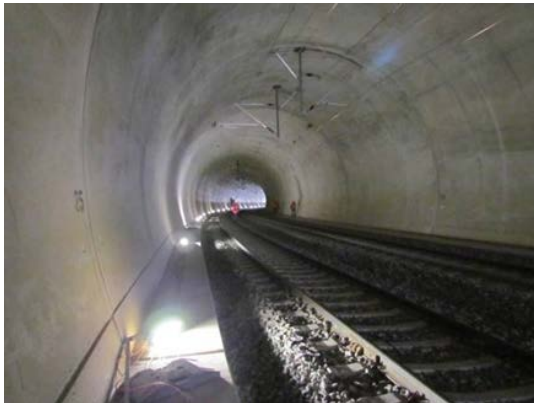
Abb. 17: Innenschale mit Gleisoberbau
