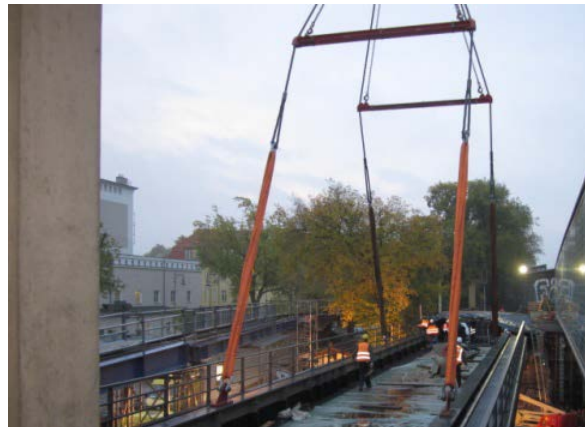
Abb. 12: Montage des Stahltrögs in zugehöriger Endlage
