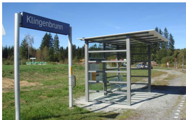
Abb. 26: Wetterschutzhäuser aus dem OpEx-Programm in Klingenbrunn; Quelle: DB Station&Service AG
