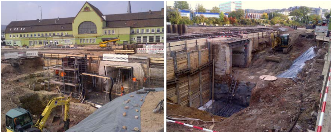
Abb. 51: Herstellung Erschließungsbauwerk Bosenheimer Straße und Zuwegung Unterführung, Quelle: F. Höflich
