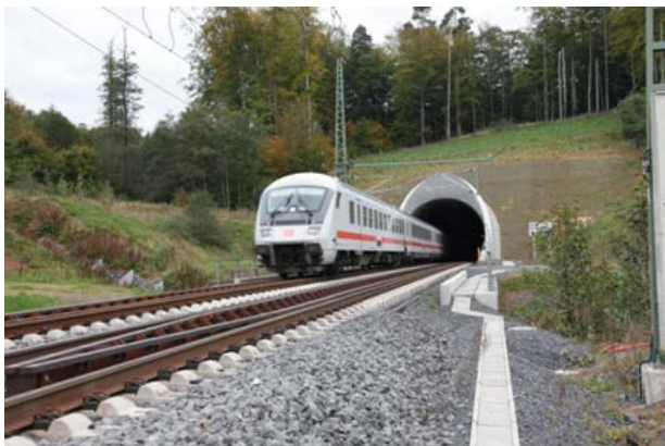
Abb. 26: Tunnelportal des Neuern Schlüchterner Tunnels
