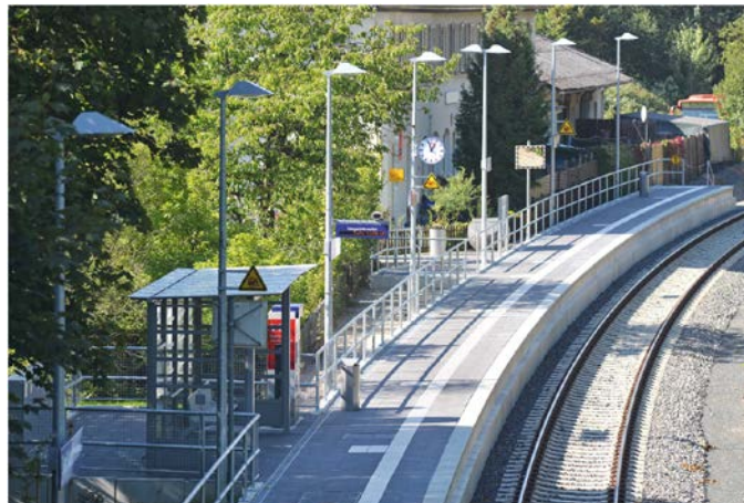
Abb. 29: Bad Karlshafen Erneuerung Bahnsteig, Foto: Christian Bedeschinski
