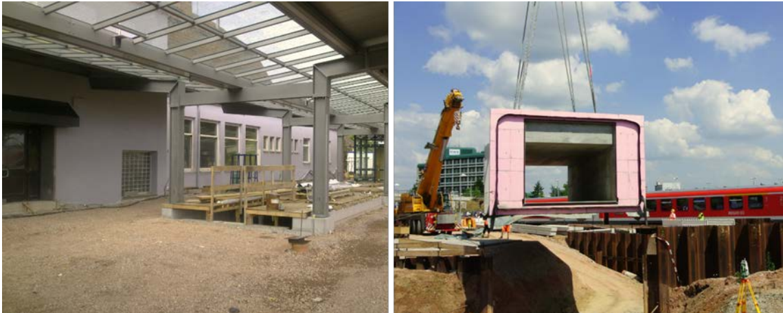
Abb. 52: Bahnsteig 1 mit neuer Zuwegung in Richtung Personenunterführung und Einhub des in Ortbetonbauweise hergestellten PU-Teilelementes unter den Gleisen 1 und 2, Foto F. Höflich
