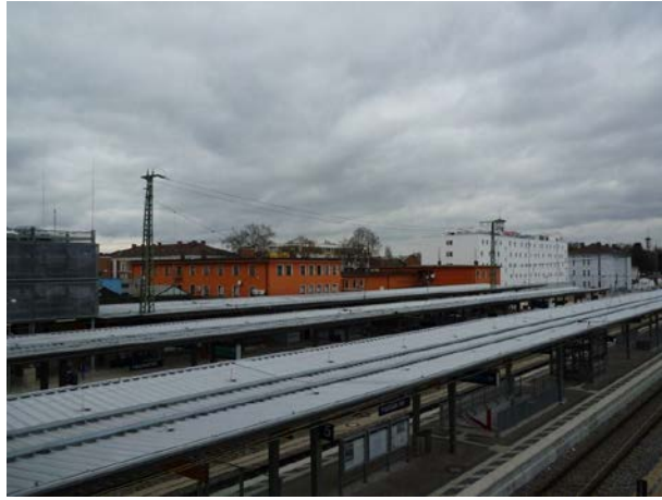
Abb. 45: Blick von oben auf die umgebaute Verkehrsstation, Quelle: DB ProjektBau GmbH
