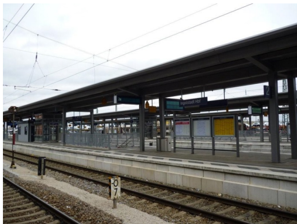
Abb. 47: Mittelbahnsteig Gleis 2/3 mit Aufzug und neuem Dach, Quelle: DB ProjektBau GmbH
