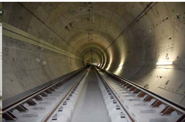
Abb. 27: Feste Fahrbahn und Tübbingschale NST
