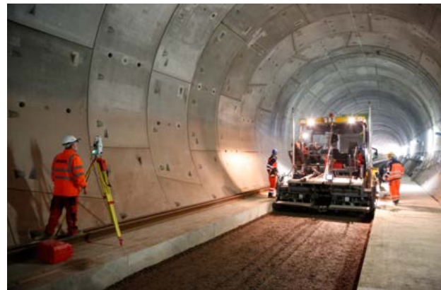
Abb. 25: Einbau der festen Fahrbahn innerhalb des Tunnels
