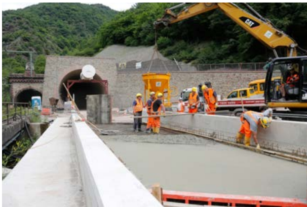
Abb. 24: Portal neuer Kaiser-Wilhelm-Tunnel in Ediger-Eller mit Einbau Fester Fahrbahn
