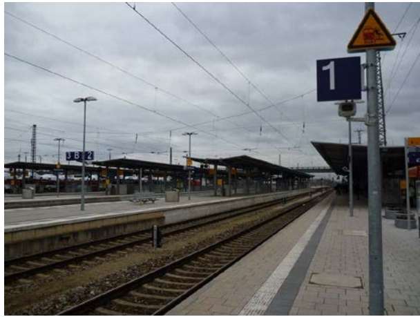
Abb. 46: Blick vom neuen Hausbahnsteig auf die umgebaute Verkehrsstation, Quelle: DB ProjektBau GmbH
