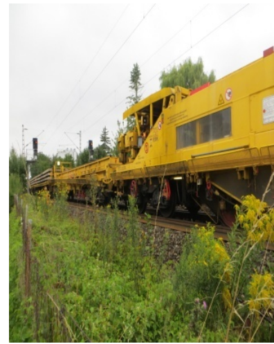
Abb. 3: Großmaschinen bei einer Baudurchführung
