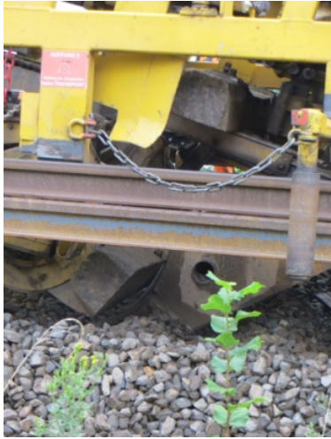
Abb. 1: Großmaschinen bei einer Baudurchführung
