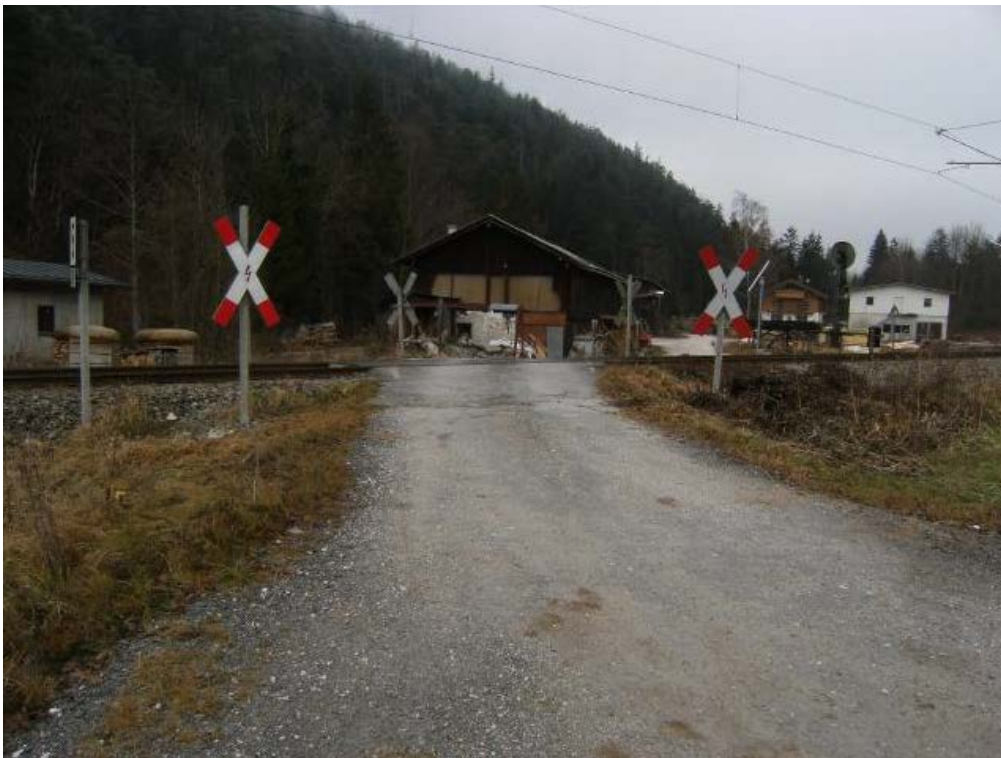
Abb. 12 Bahnübergang bei km 12,738 mit Blick von der B20 (Quelle: PD München, DB Netz AG, Ortsbesichtigung 16.08.2012).
