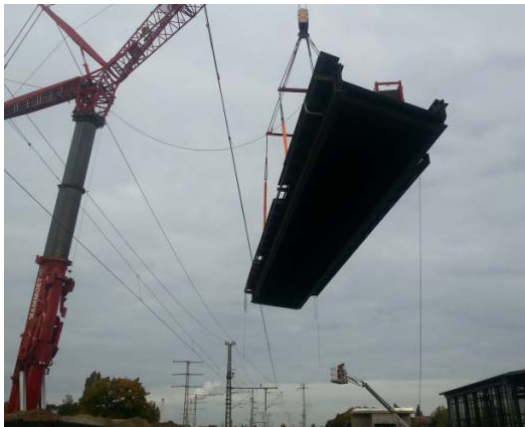
Abb. 11: Stahltrög an Teleskopkran über Fernbahn hinweg
