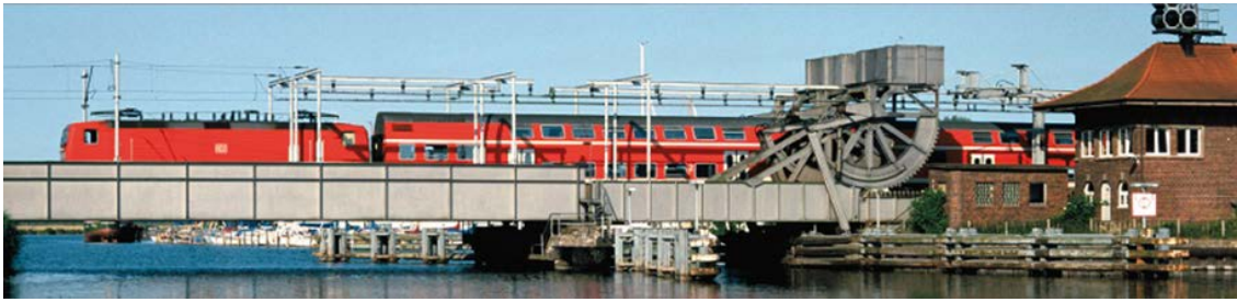
Abb. 7: Die neue Peeneklappbrücke, Quelle: DB Projektbau GmbH
