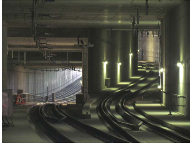
Abb. 22: City-Tunnel Leipzig, Nordrampe Hauptbahnhof Leipzig, Quelle: DB Netz AG
