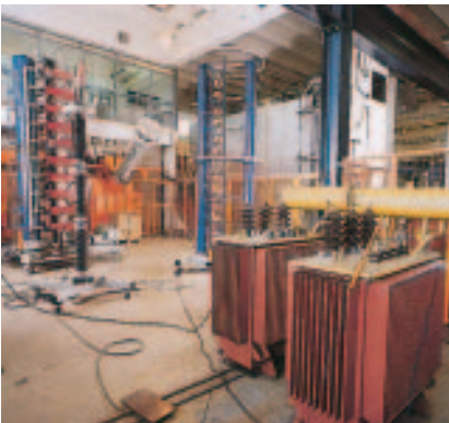
Σχ. 1.28: Δοκιμαστήριο Μ/Σ.
