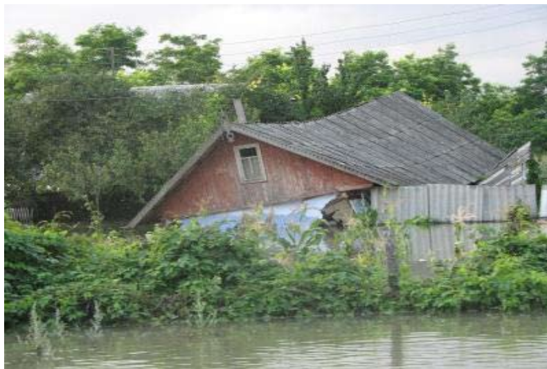
Фото 2. Разрушение строений и домов
