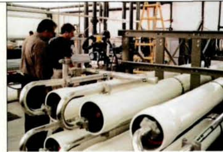
Instandsetzung der Wasserversorgungsnetze im Gazastreifen/Westjordanland
