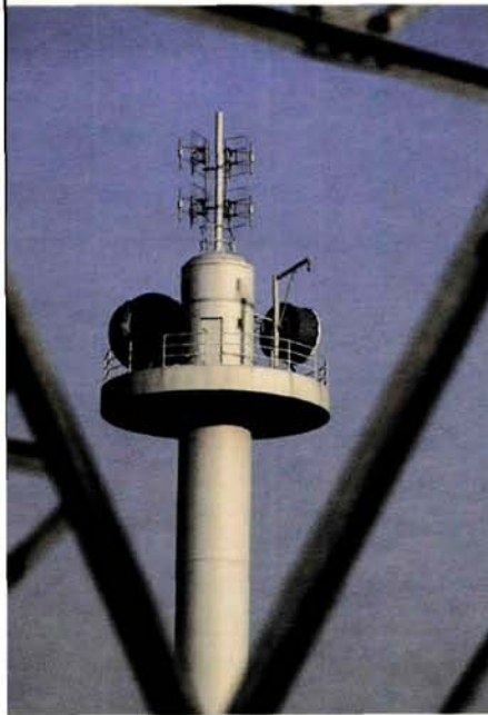
Ausbau des Telekommunikationsnetzes
