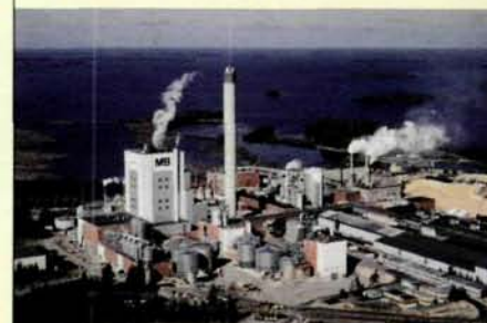
Modernisierung einer Zellstofffabrik in Joutseno
