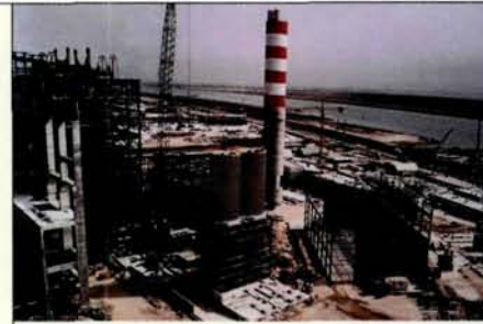
Müllverbrennungsanlage mit Stromerzeugung in Lissabon
