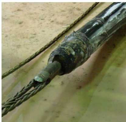
Cabezal de tiro. Fuente: Red Eléctrica.
