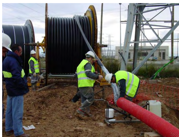
Extracción del cable de la bobina. Fuente: Red Eléctrica.
