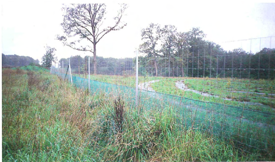
Figura 34. Tanca perimetral dissenyada per a grans mamífers que s'ha reforçat a la part inferior per evitar que amfibis, rèptils o altres animals de petites dimensions puguin traspasar-la.
