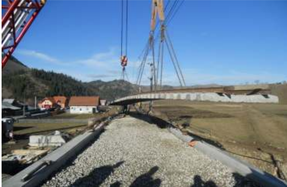
Figura 2.57. Manipularea unui panou de cale ferată cu macaraua
