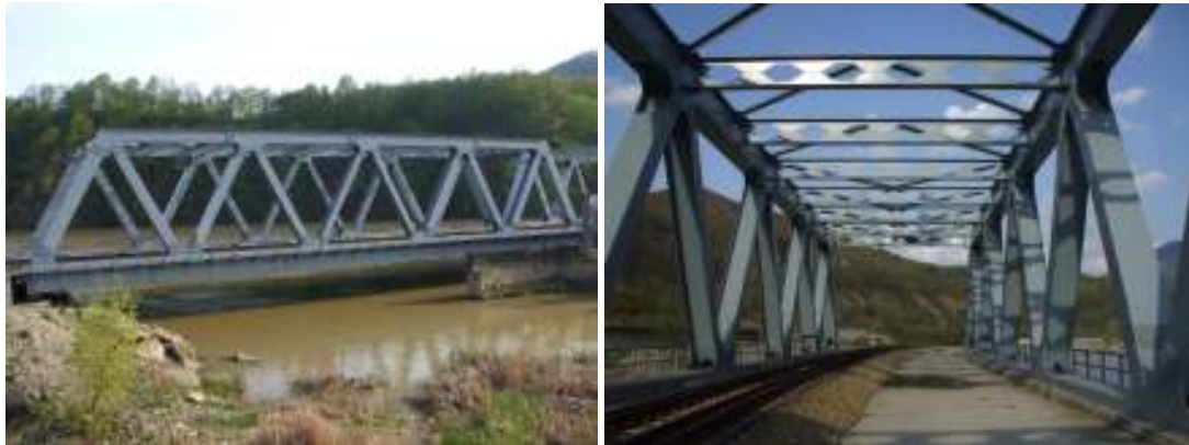
Foto 2.19. Exemplu de pod cu tablier de tip GZCJ
