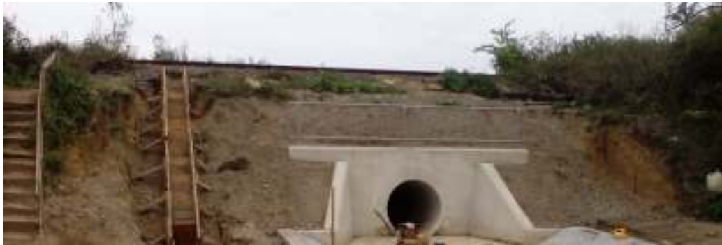
Foto 2.14. Podeț alcătuit din tuburi prefabricate
