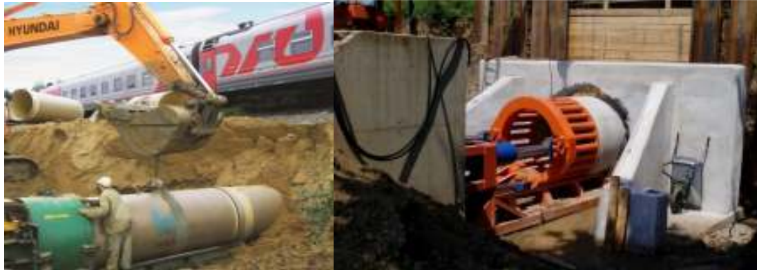
Figura 2.55. Metoda de execuție Pipe-Jacking
