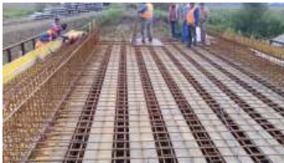
Foto 2.17. Pod cu tablier grinzi metalice înglobate în beton
