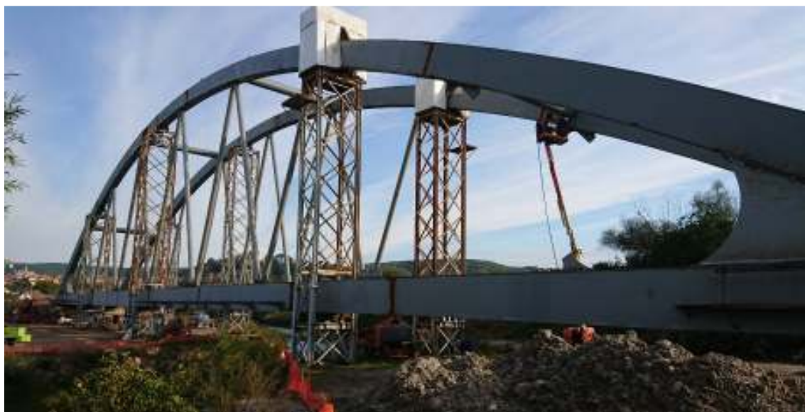
Figura 2.60. Manipularea unui tablier metalic de pod cu turnuri de montaj
