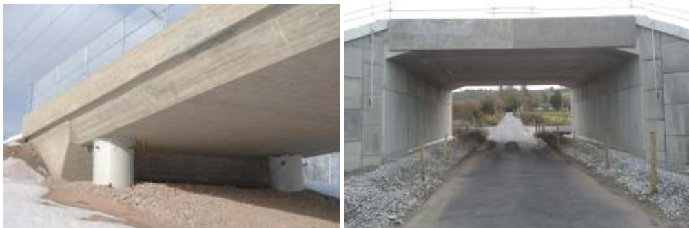
Foto. 2.15. Exemple de poduri integrale
