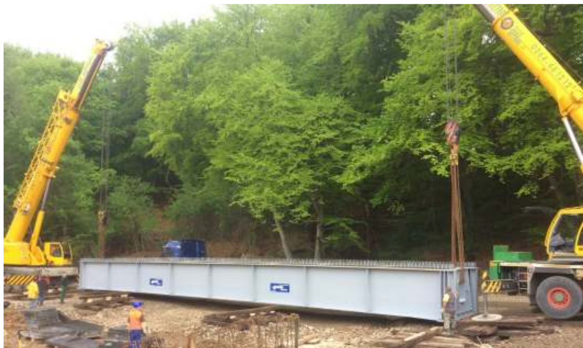
Figura 2.58. Manipularea unui tablier metalic de pod cu două automacarale
