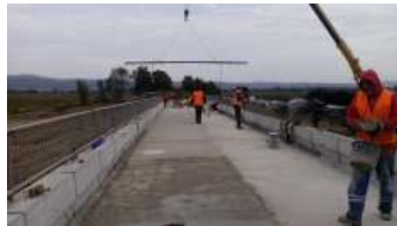
Foto 2.17. Pod cu tablier grinzi metalice înglobate în beton
