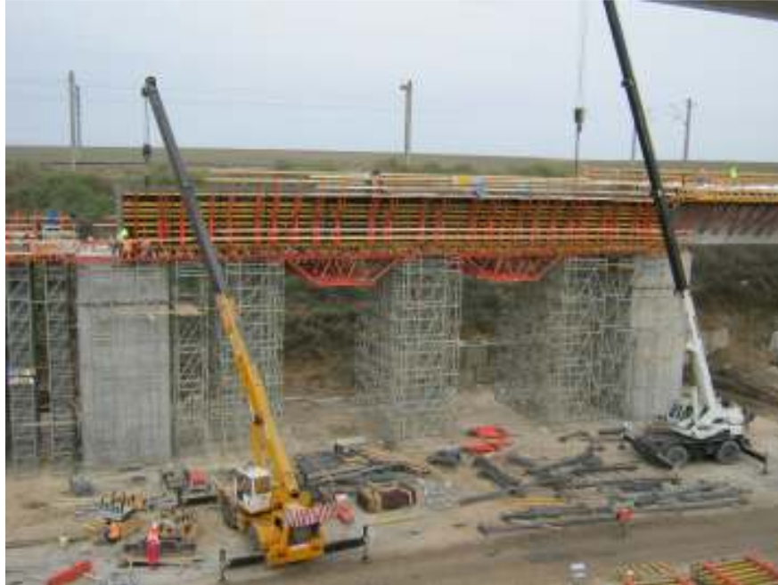
Figura 2.61. Manipularea unui pod cu suprastructură din beton, pe schele de montaj
