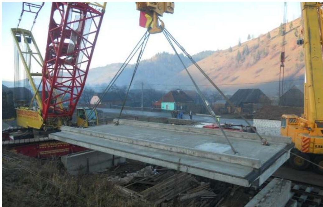
Figura 2.59. Manipularea unui tablier din beton
