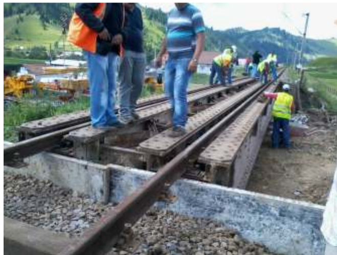
Figura 2.54. Pod provizoriu montat în cale pentru execuția infrastructurii podului definitiv
