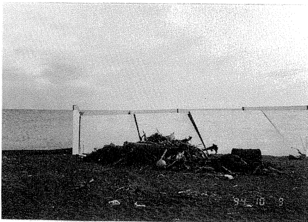
写真-4.3.2 野付岬での防波堤の被害 野付岬での地盤の液状化によるとみられる防波堤の沈下。 Photo-4.3.2 Subsidence of Quay at The Notsuke Peninsula due to Liquefaction.
