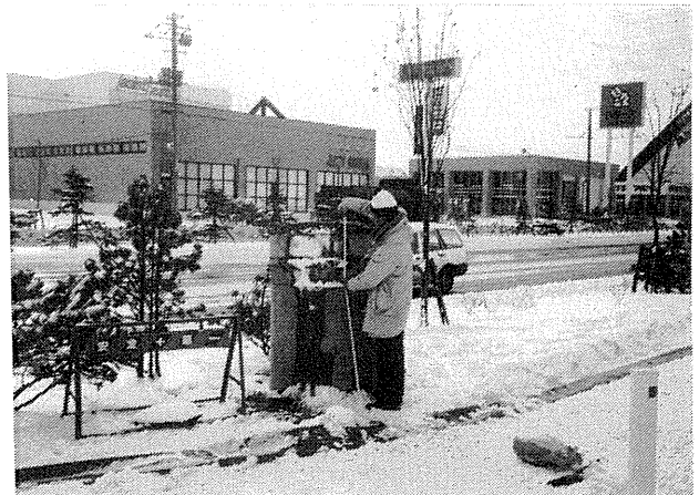
写真-3.2.1 釧路町桂木 釧路沖地震によるマンホールの浮上 下水道マンホールが液状化により約25ヶ所で浮上した。写真は最大に浮上（約1.4m）したニチイ前のマンホール。 Photo-3.2.1 Lift-up of Sewage Manhole (Katsuragi, Kushiro City)
