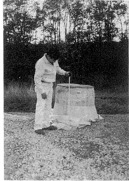
写真-4.2.12 宅地造成地内の下水マンホールの浮上 中標津町東十条地区の宅地造成地では、液状化により 下水マンホールが最大約90cm浮上していた。また、付近 に敷設されている下水の落込管も同様に浮上していた。 Photo-4.2.12 Lifting of Sewage Manhole (Higashi Jujo District) Due to liquefaction a sewage manhole lifted at maximum.
