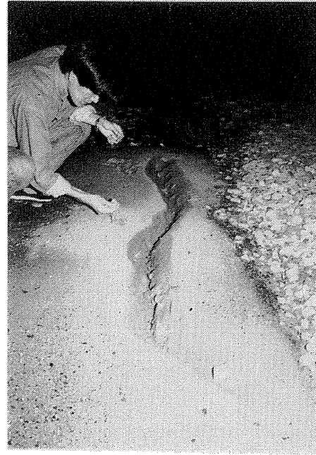
写真-3.3.5 庶路川左岸側河川敷での噴砂 国道38号庶路橋下流側の庶路川左岸側河川敷で液状化による噴砂と地割れが発生した。 Photo-3.3.5 Sand Boil at Left Bank of Shoro River
