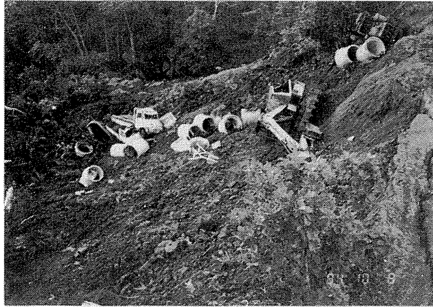
写真-4.2.4 りんどう大橋下の斜面の崩壊 りんどう大橋下の沢の斜面が幅100m近くにわたって崩壊した。 Photo-4.2.4 Ground Sliding near The Rindo Bridge Ground over 100 m length largely slid near the Rindo Bridge.
