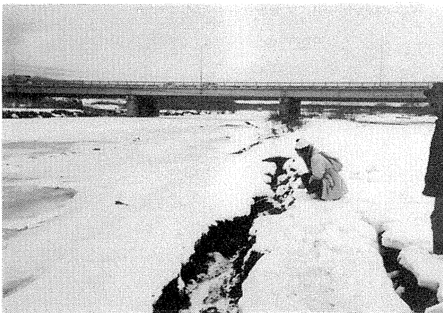
写真-3.3.6 釧路沖地震による庶路川左岸側河川敷の地盤流動 釧路沖地震では液状化により50cm～1m程度河心方向へ地盤が流動していた。 Photo-3.3.6 Lateral Movement of Left Bank of the Shoro River during 1993 Kushiro-oki Earthquake
