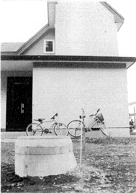
写真-4.2.13 液状化の被害を受けなかった住宅 東十条地区の宅地造成地では、液状化により建物の基礎部分に 地盤の沈下等の被害を受けていたが、写真の民家では基礎に砂 利を敷き詰めていたために過剰間隙水圧を低減させ被害を受け なかった。
