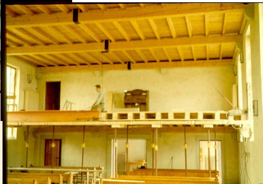
Durch die geöffnete Kirchenwand wird der Stahlträger eingezogen. Gut zu sehen: das alte Harmonium
