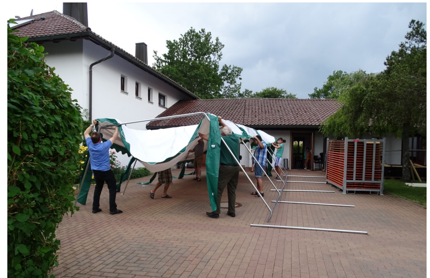
Aufbauarbeiten für das Gemeindefest, seit 2015 mit unserem eigenen Zelt
