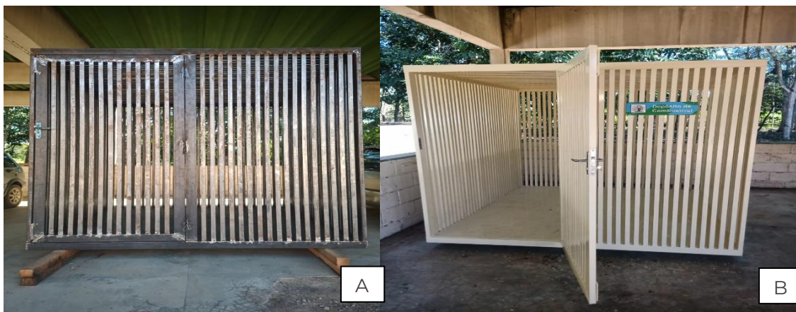
Figura 2. Depósito de combustível A) B) Ação de pintura com a aplicação de três demão de tinta esmalte sintético em toda estrutura do depósito de combustível.
