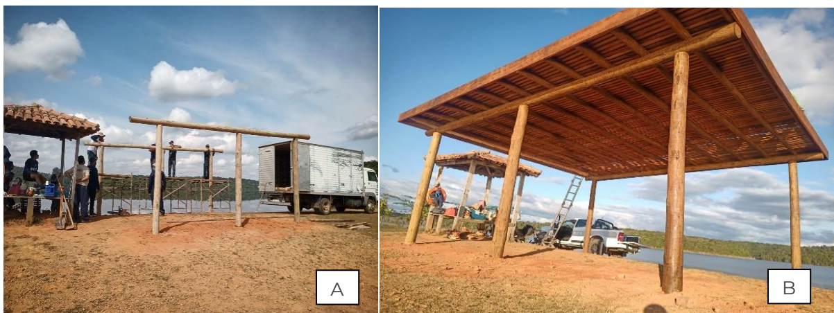
Figura 9. Prainha Dom Helvécio A) B) Construção de pergolado na área de banho no lago Dom Helvécio
