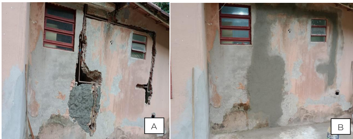
Figura 30. Casa das Flores A) B) Manutenções de todas as partes hidráulicas. Reparos finalizados com areia, cal e cimento nas paredes da estrutura.
