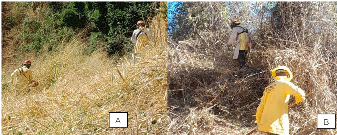
Figura 13. Alphaville A) B) Construção de 485 metros de aceiros com 3 metros de larguras no entorno das áreas onde foi realizada a queima controlada de material inflamável, próximo aos bairros Rocinha e Alphaville, município de Timóteo.
