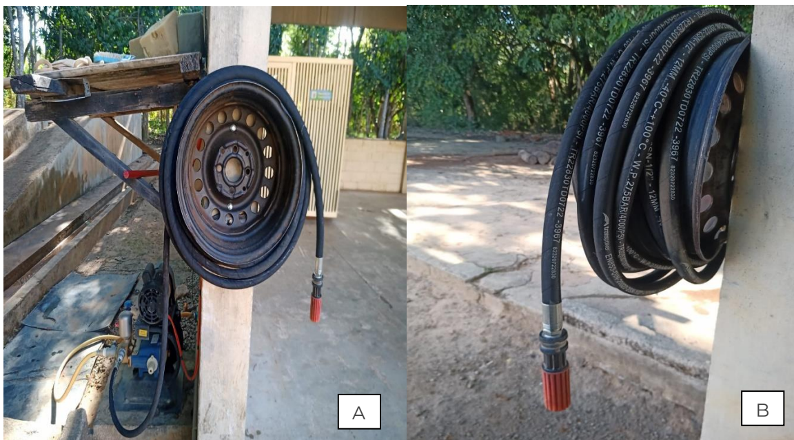
Figura 36. Centro de Manutenção A) B) Aquisição e instalação de mangueira \frac{1}{2} polegada de Alta Pressão, com 2 tramas de aço e 15 metros de comprimento para higienizações dos veículos da UC.
