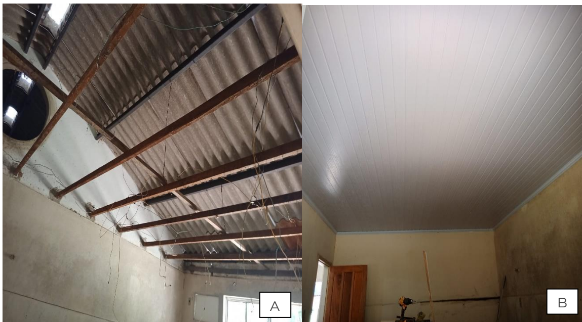
Figura 32. Biblioteca A) B) Finalizada montagem de forro em PVC em sala de armazenamento de materiais didáticos, próxima ao Herbário.
