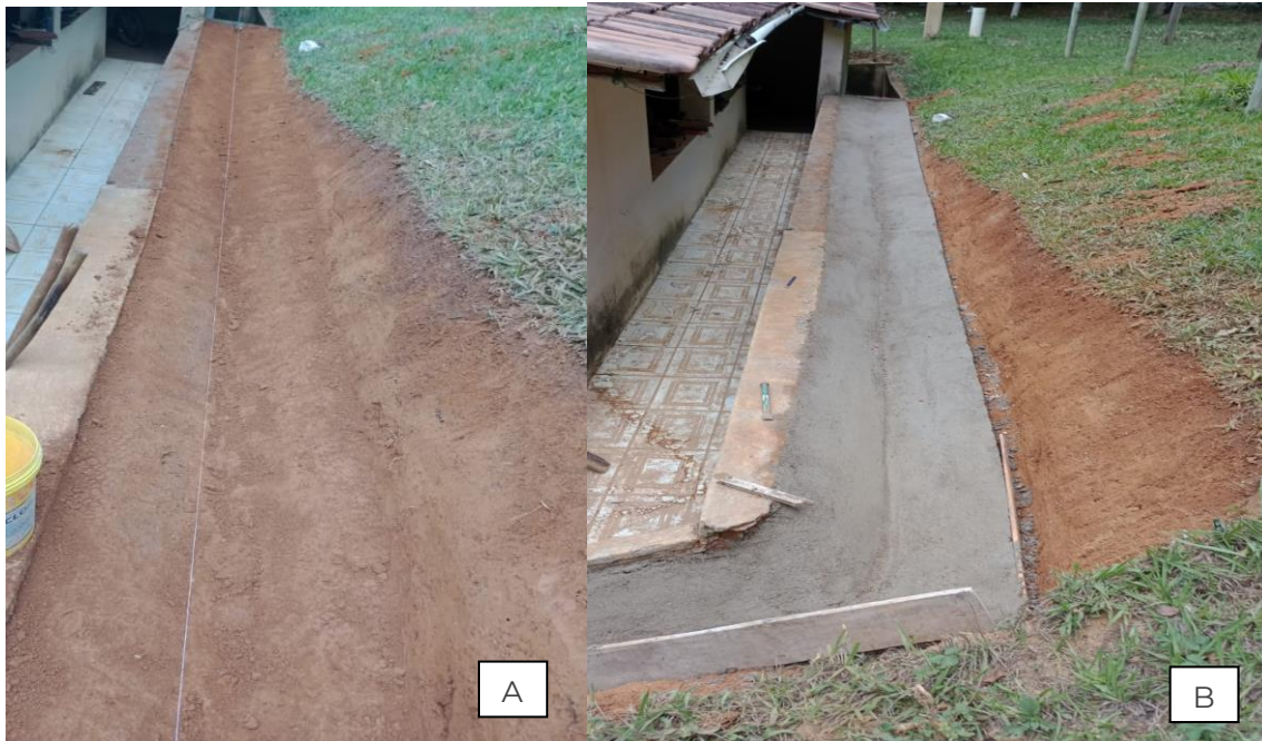
Figura 42. Casa das Flores A) B) Construção de canaletas em concreto armado, areia, cimento e brita, com a finalidade de eliminar futuras infiltrações no entorno da estrutura.
