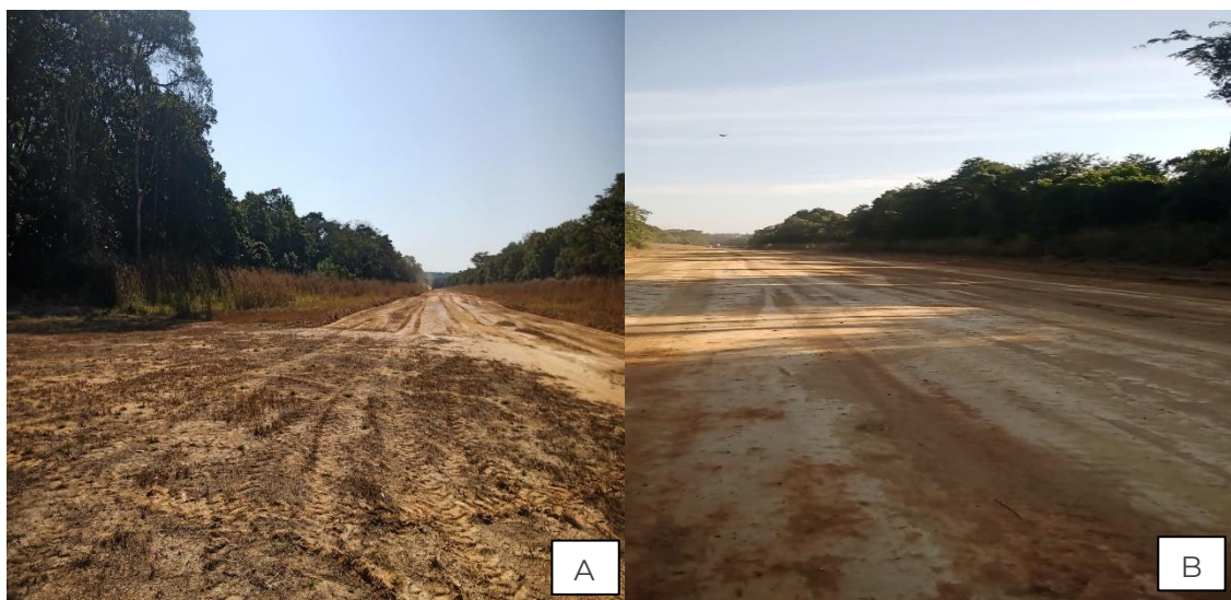
Figura 12. Campo de pouso A) B) Com a chegada do período crítico (risco de incêndio) foi realizada a limpeza de toda extensão da pista de pouso com uma Motoniveladora e uma Carregadeira, ambas cedidas pela prefeitura de Marliéria.
