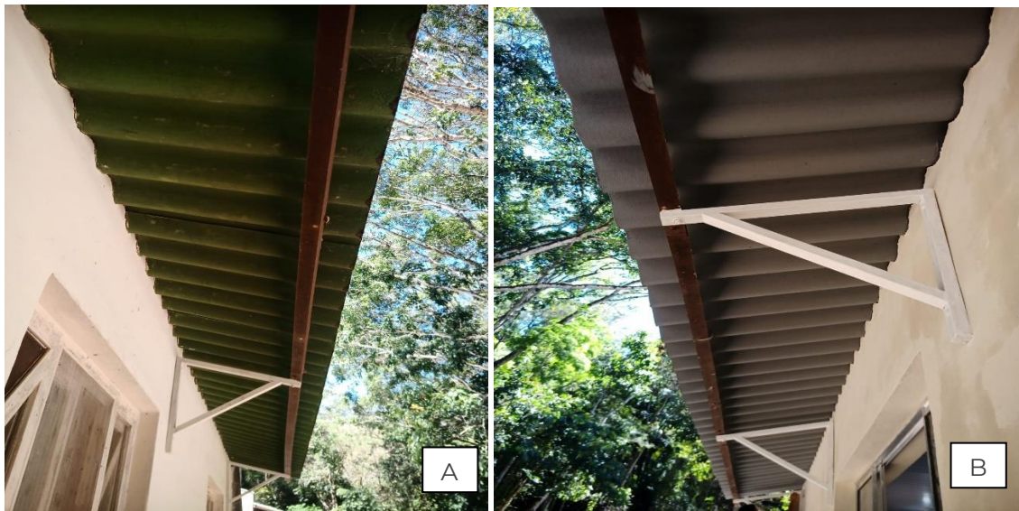
Figura 38. Herbário e Laboratório A) B) Limpeza e pintura com três demão de tinta extra cinza escuro em toda área externa do beiral do telhado das estruturas.
