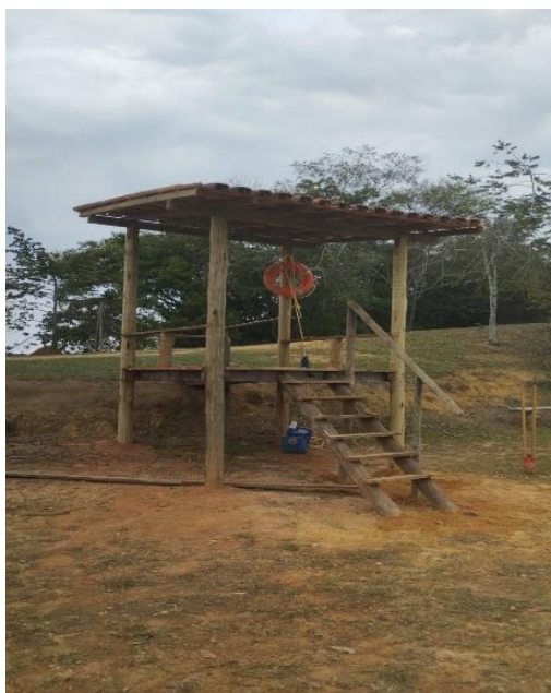
Figura 25. Ponto salva vidas A) B) Construção de estrutura de madeira para acolher os agentes salva vidas em ponto estratégico com maior visibilidade dos banhistas, próximo à área de banho no lago Don Helvécio.
