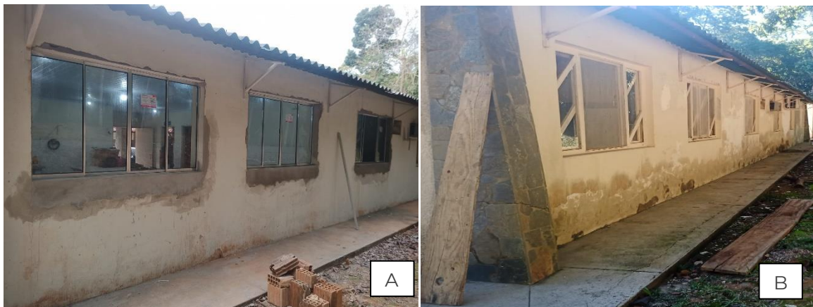
Figura 15. Centro de Pesquisa A) B) Substituição de janelas de metal enferrujadas por janelas de alumínio de correr 120x200cm, com 4 folhas de vidro liso.
