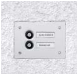
Einzigste Voraussetzung: Eine Klingelanlage, hier für ein Zweifamilienhaus
