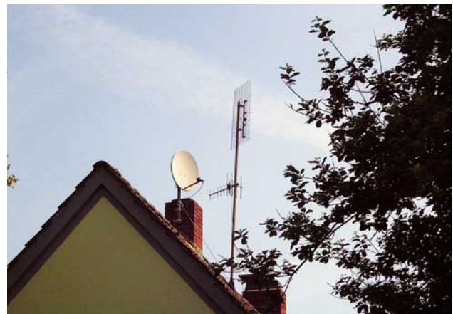
Bild 4: Antenne befindet sich im gefährdeten Bereich (weniger als 2 m unterhalb der Dachkante – siehe Bild 1)
