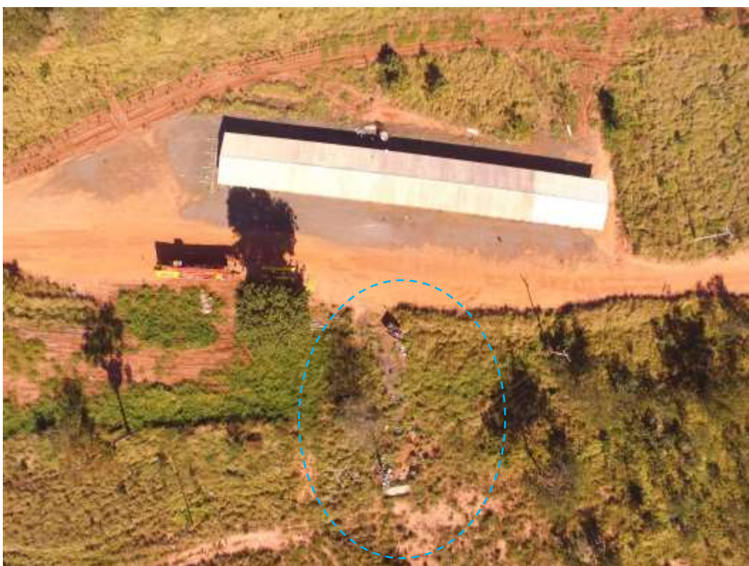
Figura 14. Depois (julho/2019) – Caçambas e resíduos próximos ao alojamento ocupado pela Seta, entrada da casa de hospedes.
