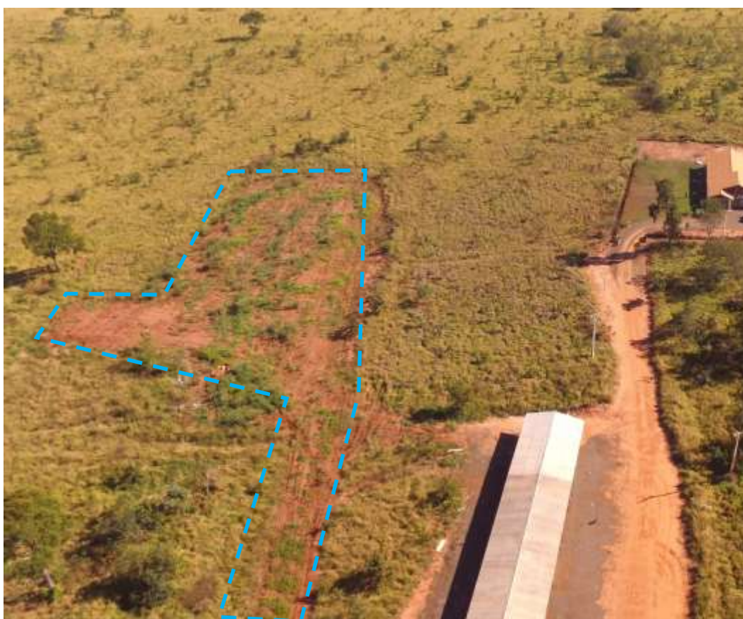
Figura 18. Depois (julho/2019) - Área do antigo bloco dos alojamentos operacionais e acesso. Imagens com Drone, indicação polígono azul. O solo foi reposto e realizado plantio recente por sementeira, ainda há áreas sem vegetação cobertura do solo em 80%.
