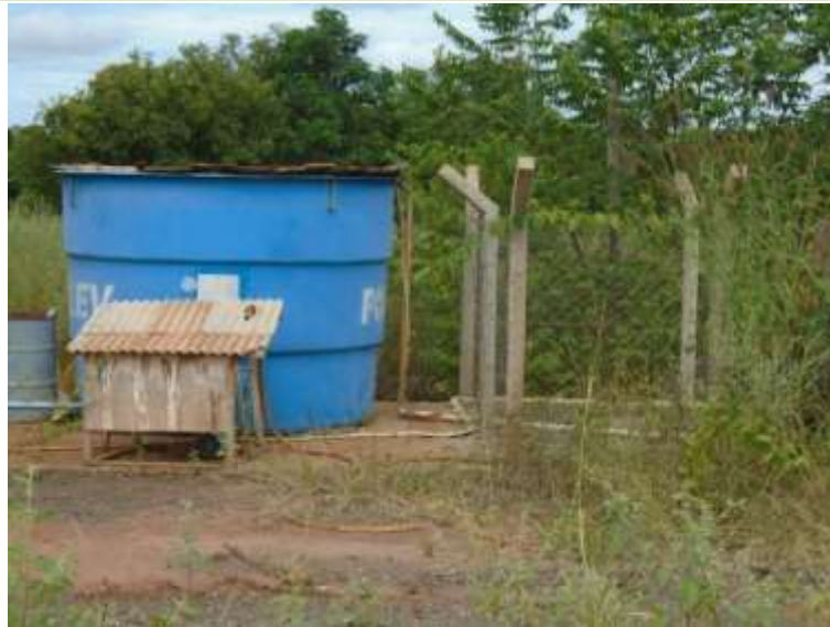
Figura 15. Antes (maio/2019) – Desativar, tamponar poço 02, e recuperar área.
