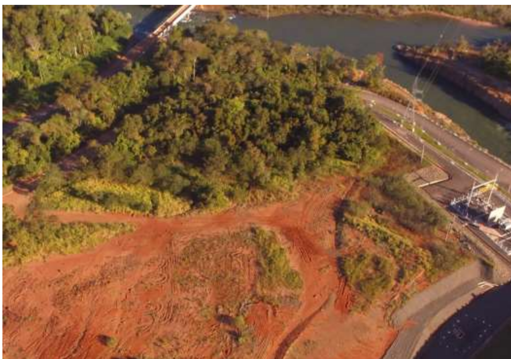
Figura 8. Depois (julho/2019) – Área do entorno do poço de alívio e bota fora e subestação, imagens obtidas com Drone. A semeadura não teve resultado satisfatório verificamos a presença de feijão Gandu e Grama Batatais em baixa densidade.
