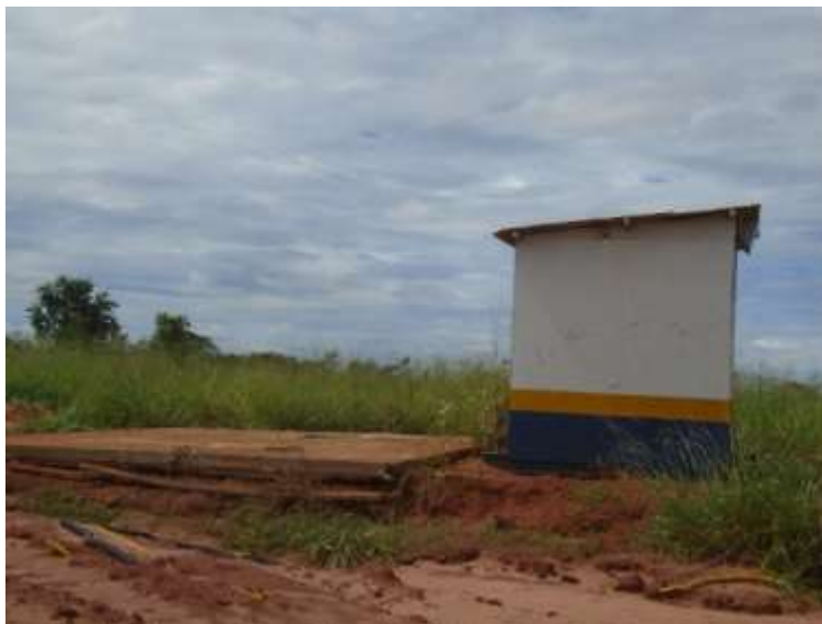
Figura 11. Antes (maio/2019) - Estrutura próxima ao antigo bloco de alojamentos operacional e piso de concreto.
