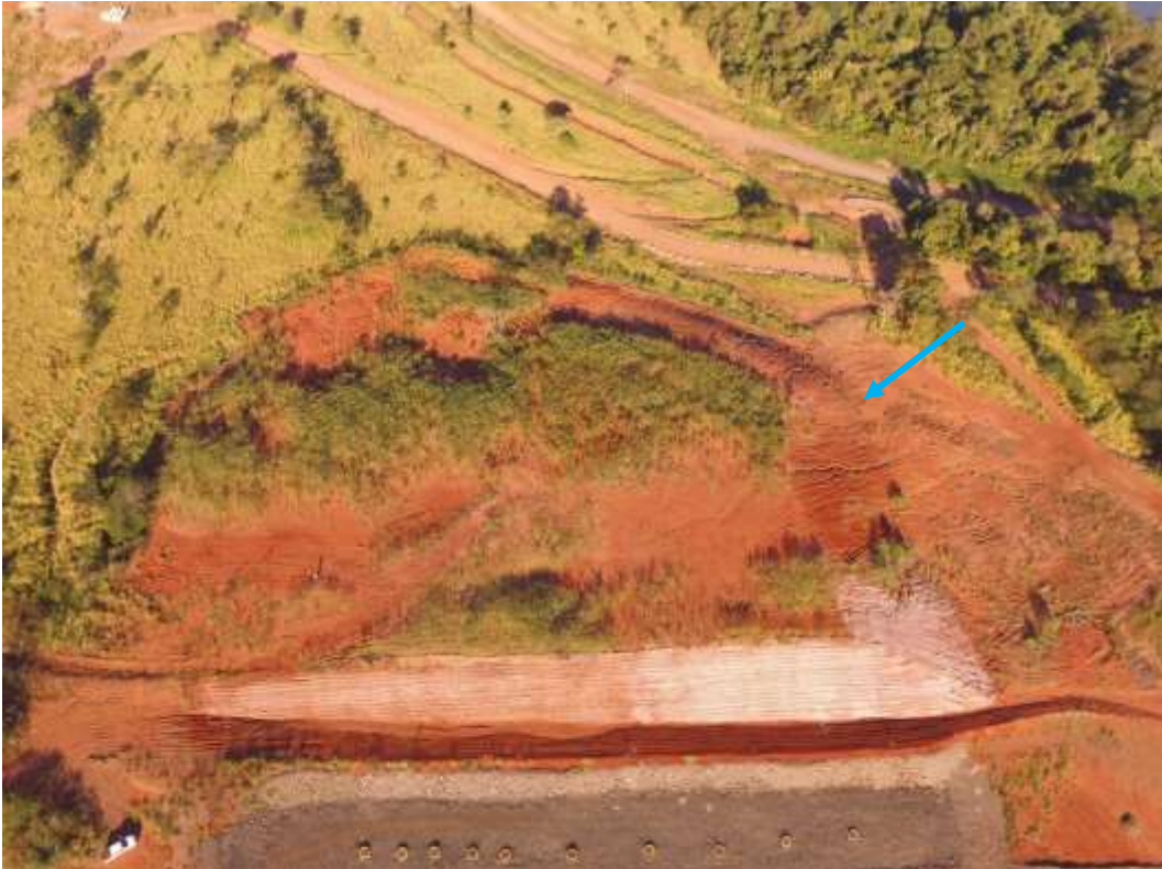
Figura 6. Depois (julho/2019) – Área do entorno do poço de alívio, imagens obtidas com Drone. Parte do talude foi realizado hidro-semeadura, faltando a área indicada pela seta Azul. O platô a semeadura não teve resultados satisfatórios verificamos a presença de feijão Gandu e Grama Batatais em baixa densidade.
