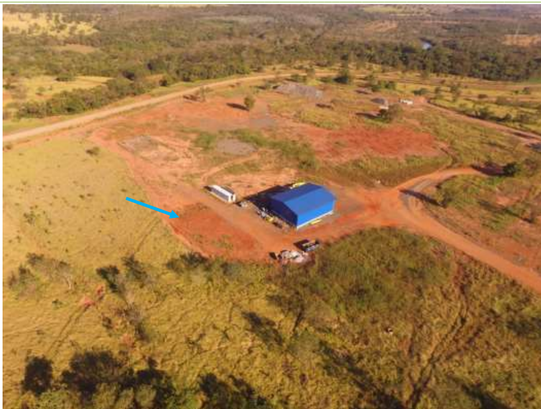
Figura 4. Depois (julho/2019) – Área próxima ao almoxarifado e britador, imagens obtidas com Drone. Não há vestígio de reposição de solo e replantio na área indicada no relatório de maio de 2019. O solo foi revolvido na área de depósito de resíduos (indicado pela seta Azul).
