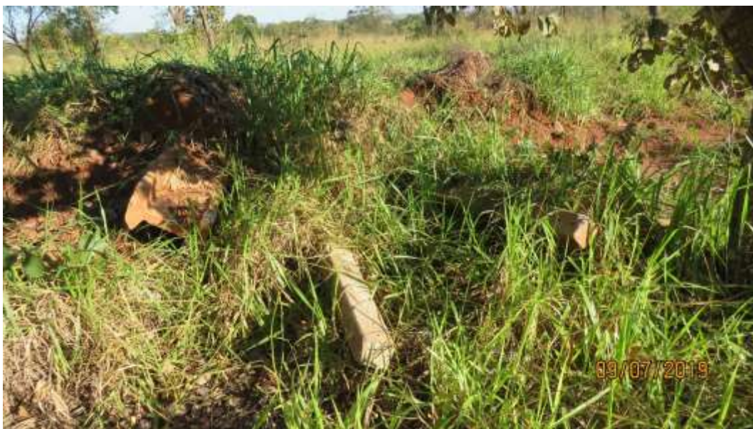
Figura 24. Depois (julho/2019) - Área próxima à oficina, postes parcialmente enterrados.
