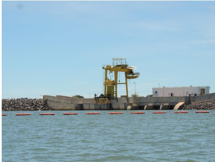
Figura 10. Log-boom da PCH Verde 4A, Água Clara/MS. Fevereiro de 2019.
