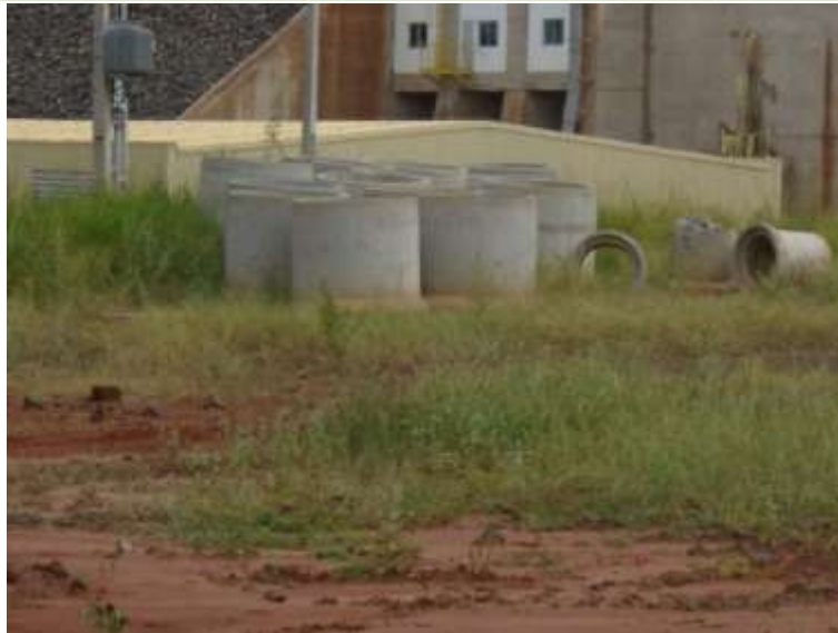
Figura 19. Antes (junho/2019) – Manilhas de concretos próximo ao poço de alívio.
