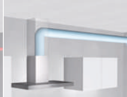
Beispiel einer guten Verrohrung
