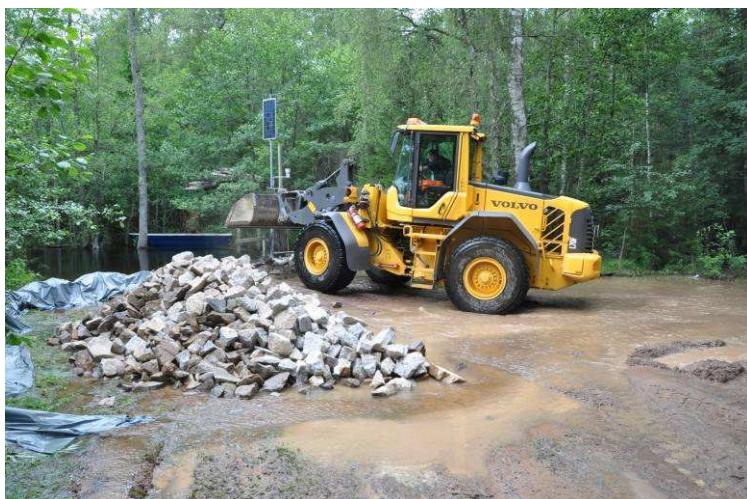
Figur 4. Reparationsarbete i samband med sommaröversvämning 2012.
