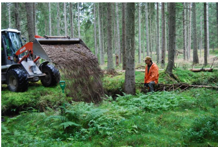
Utläggning av lekgrus i ett litet biflöde till Nissan vid Spafors.
