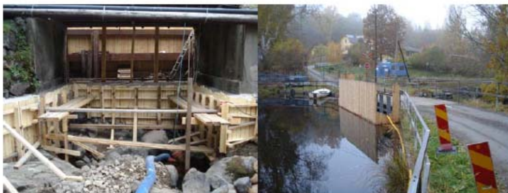
Figur 3. Reparation av dammfästet vid Hjorteström under augusti och september 2009.
