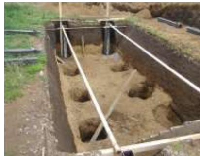
Instalación de fundaciones
