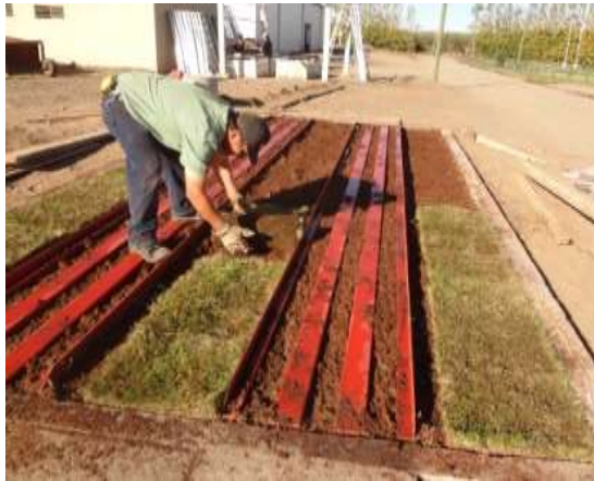
Instalación de césped
