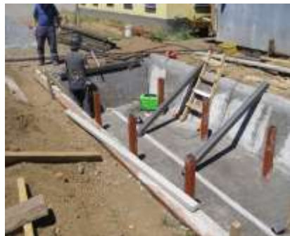
Instalación de travesaños
