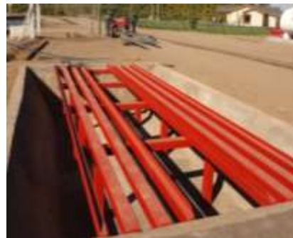
Instalación de rampa
