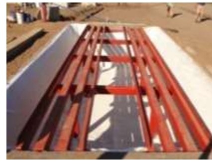
Instalación de geotextil
