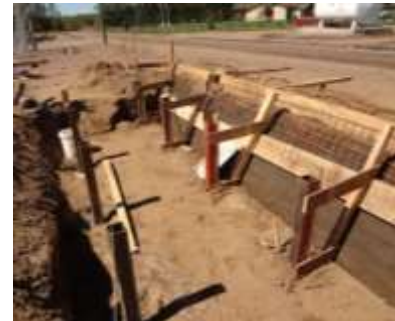
Instalación de malla
