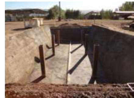
Revestimiento con hormigón
