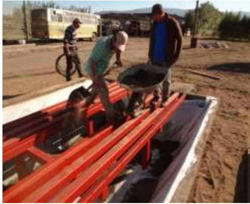
Incorporación de arena y gravilla
