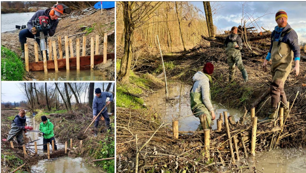
Abbildung 9: BDA-Erstellung in Handarbeit mit Unterstützung durch tragbare Pfahlramme im Kanton Thurgau.
