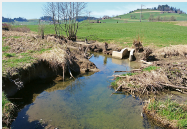
Fig. 7b Sechs Monate später: Ein Hochwasser spülte den Damm teilweise weg. Die darauffolgende Ufererosion liefert das notwendige Substrat für die Sohlenanhebung im Unterlauf. Mit BDA können diese Uferanrisse in Lage und Ausdehnung gesteuert werden (vgl. Stadium B, Fig. 2 und Kap. «Planungsgrundsätze»). (©T. Polli)
