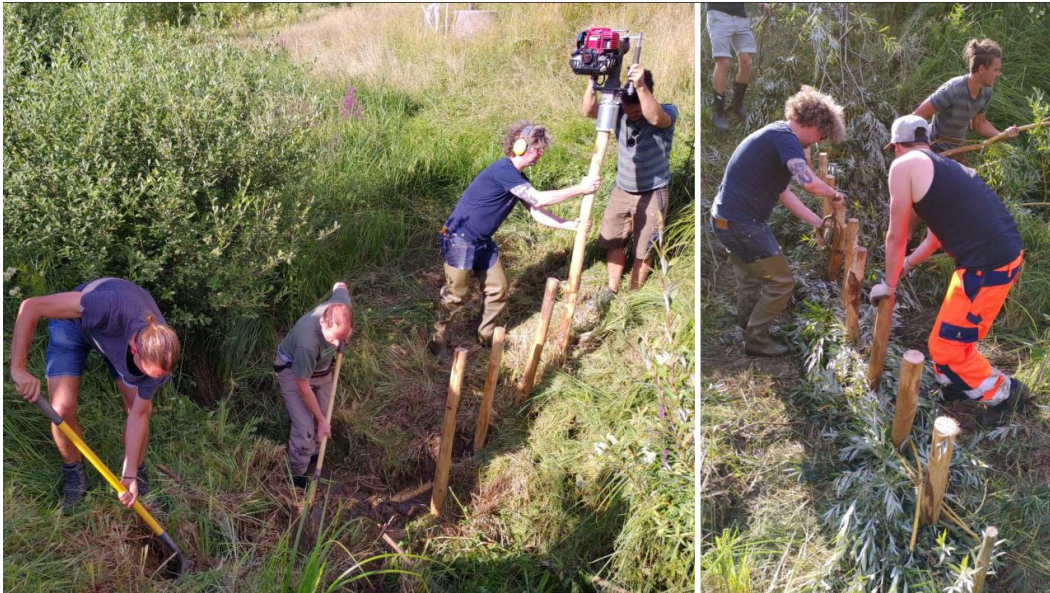
Abbildung 8: BDA-Erstellung in Handarbeit mit Unterstützung durch tragbare Pfahlramme im Kanton Bern.
