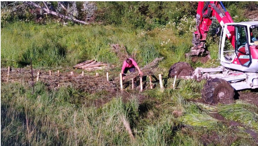
Abbildung 10: BDA-Erstellung mit Bagger (Aushub, Pfählen, Erstellen Abdichtung) und Handarbeit (Flechten).
