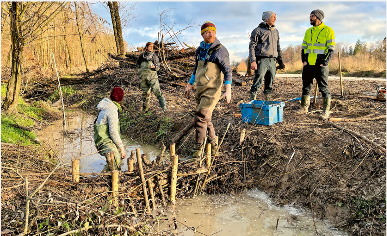
Fig. 9b Die Abdichtung der BDA wird meist mit lokal vorhandenem Material wie Ästen, Steinen und Bachsubstrat ausgeführt. Wie beim natürlichen Vorbild sind BDA stets seriell einzubauen. Sind die einfachen Initialstrukturen einmal eingebaut, verändern sie die Gewässerdynamik, schaffen wertvolle Habitate und ermöglichen über die Zeit eine naturnahe Gewässerentwicklung hin zu autotypischen Lebensräumen.
