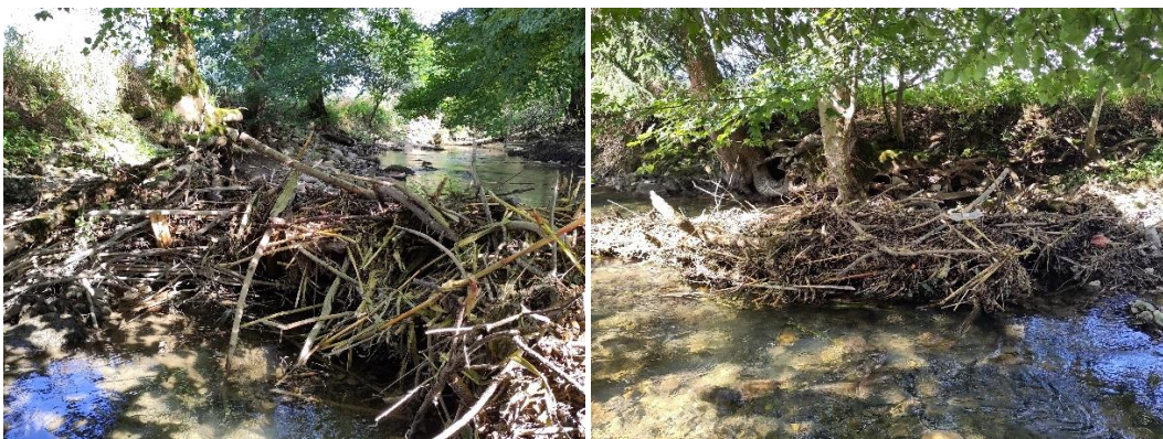
Abbildung 13: Nach einem Hochwasser gekippter BDA an der Wyna in Oberkulm, AG. Die Struktur hat sich verformt, ist aber nach wie vor in einem Stück. Es wurden keine Teile abgeschwemmt. Ursache des Kippens war die unzureichende Verankerungstiefe der Pfähle.
