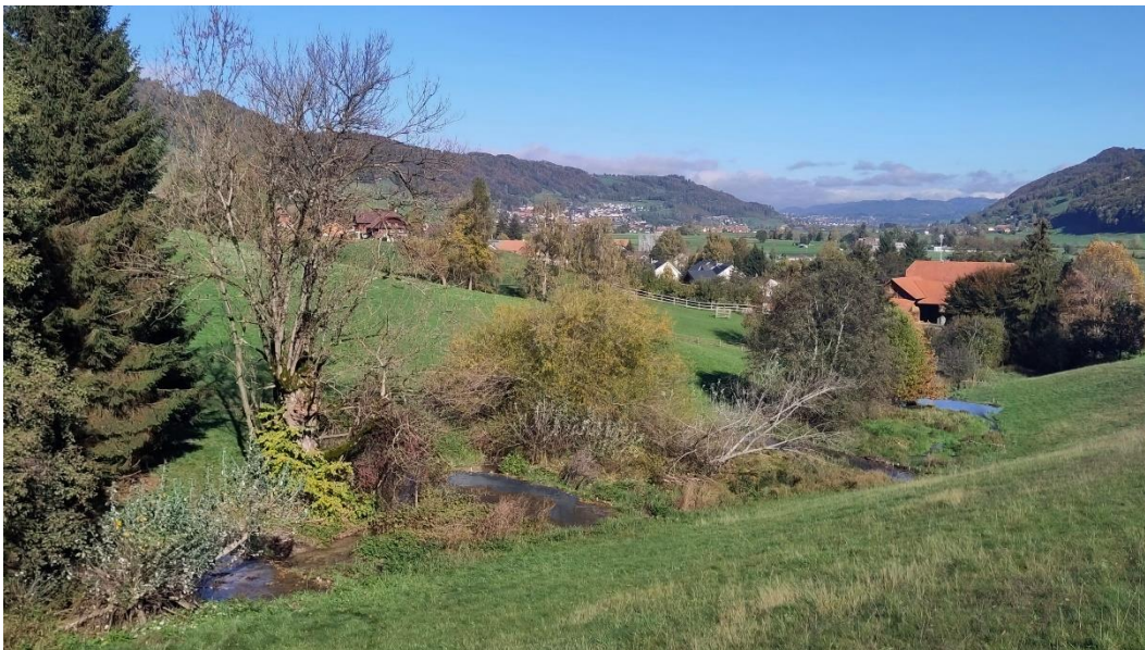
Abbildung 1: BDA-Kaskade (6 Stück) in Rümliigen, Gemeinde Rüeggisberg BE
