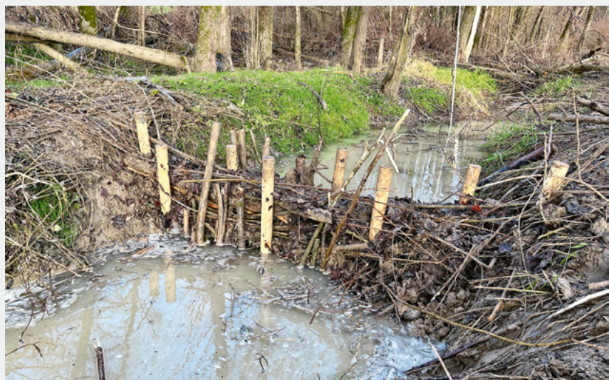
Fig. 6 BDA kurz nach der Erstellung, mit Wasserpegelanstieg um rund 10–15 cm. Der Pegelanstieg bewirkt einen Anstieg des Grundwassers (vgl. Stadium A, Fig. 2). Seriell eingebaut, kann der Wasserrückhalt selbst in kleinen Bächen stark vergrössert werden. (©S. Minnig)
