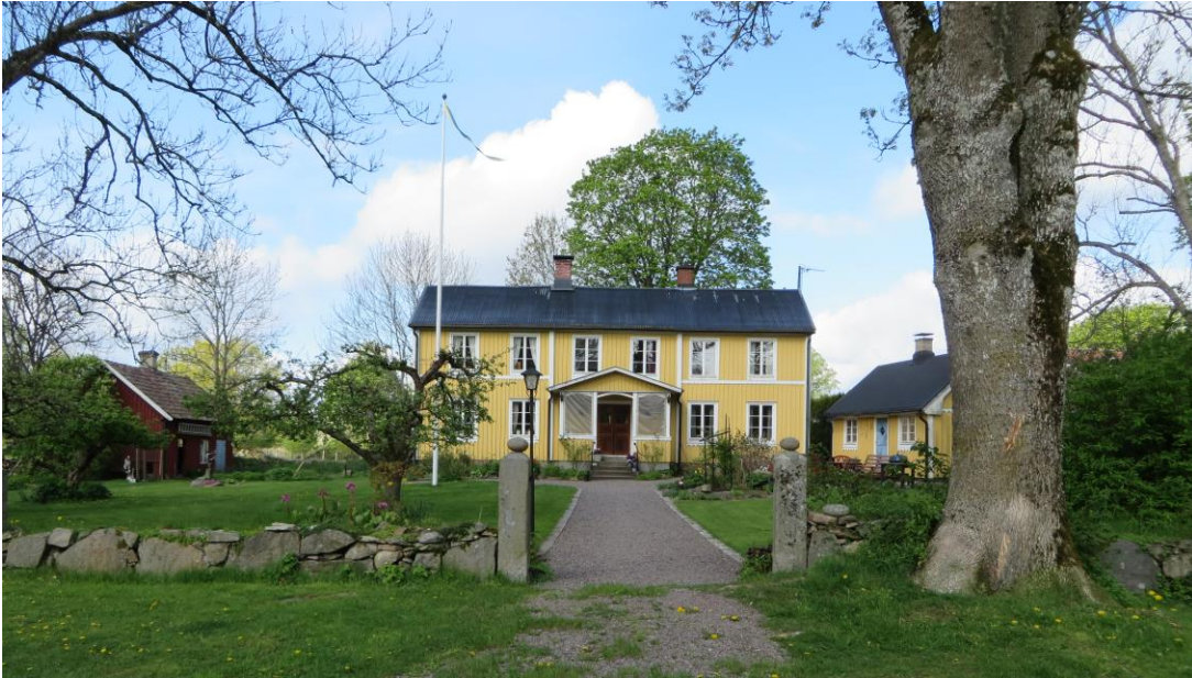
Södra Lindön 2:3. Stor mangårdsbyggnad i traditionellt utförande (om- eller nyuppförd på 1860-talet).
