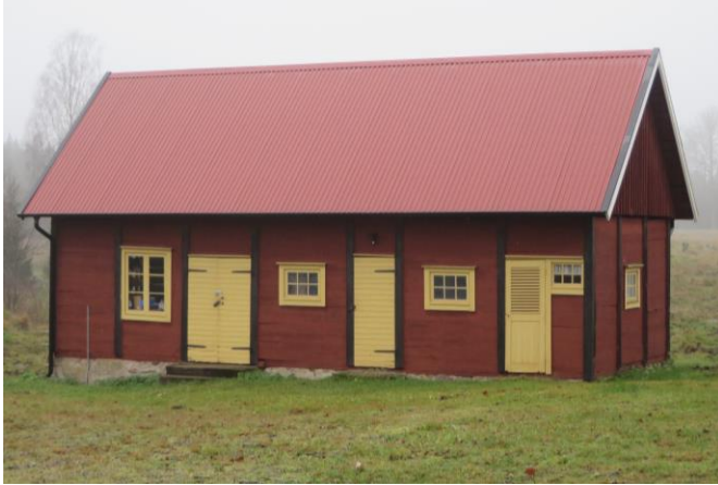
Södra Lindön 2:2, höns hus, dass mm.
