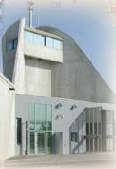
Porte d'entrée - 2010 (Source : APNET)
