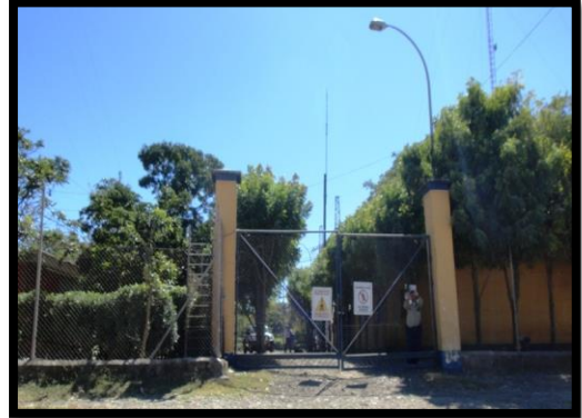
Foto N° 2 Edificios Existentes de la Subestación
