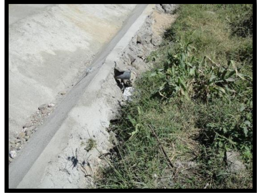
Foto N° 9 Espera del tubo pluvial con la cuneta de la calle
