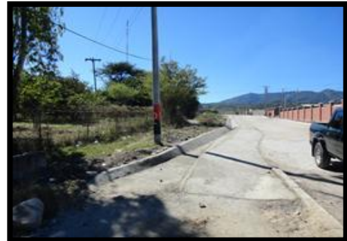
Foto N°11 Calle Adoquinada y su cuneta
