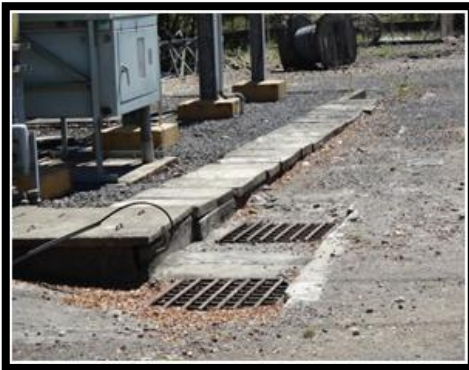
Foto N° 6 Pozo de visita
