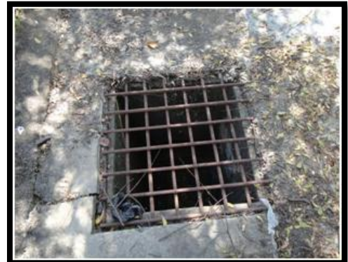
Foto N° 7 Pozo de visita
