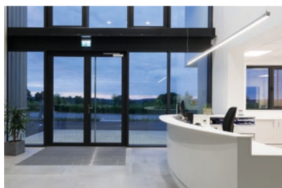
Sicherheitsbeleuchtung | Emergency luminaires
