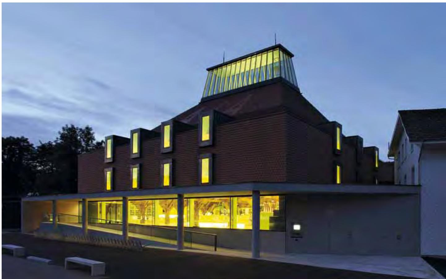
Resultat ist eine homogene Lichtverteilung mit homogener vertikaler Beleuchtungsstärke. Messungen an den Bücherregalen haben gezeigt, dass der berechnete durchschnittliche Beleuchtungsstärkewert von 200 Lux weit überschritten wird.
