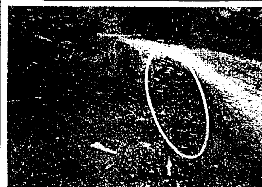
Fotografía 4. Presencia de sacos con material de relleno para aumentar la cota de dique, Fuente: visita CGH
