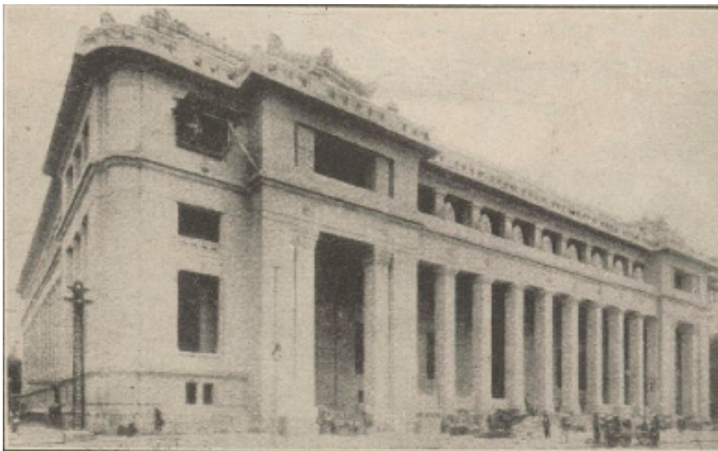
Banque de l'Indochine à Saïgon, construction en ciment armé.
