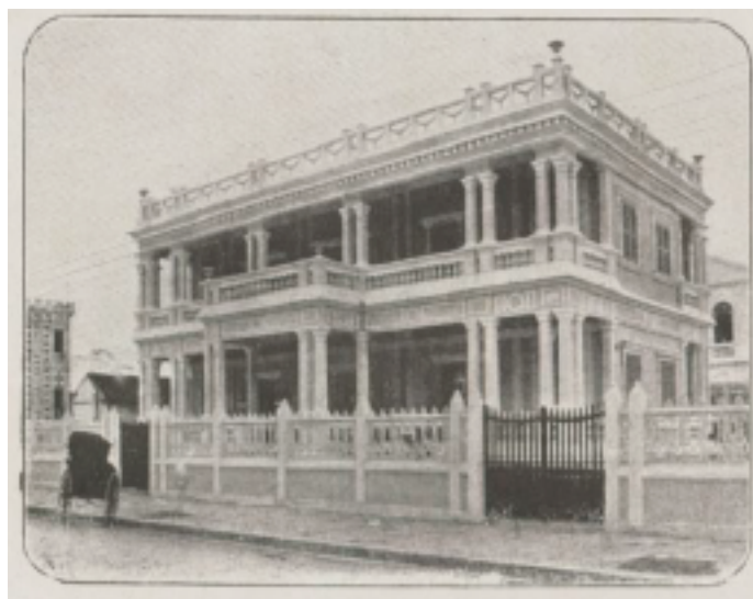
Bureaux de la direction en béton armé
