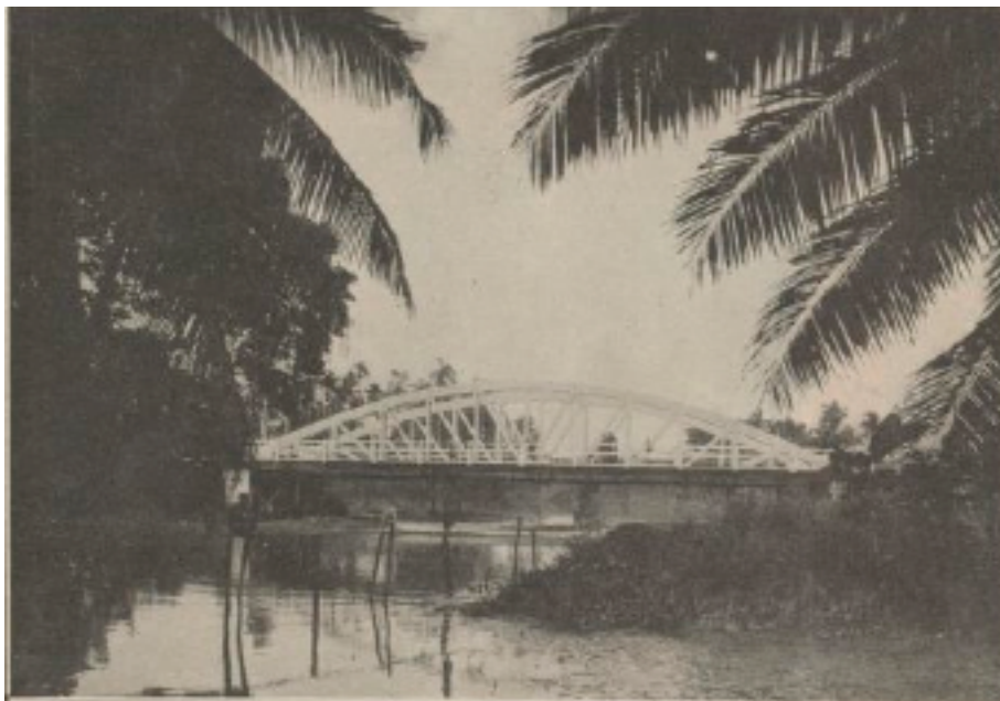
Pont en ciment armé sur la route coloniale n° 16.
