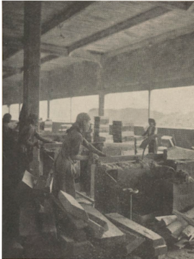
La scierie de la cimenterie d'Haïphong.
