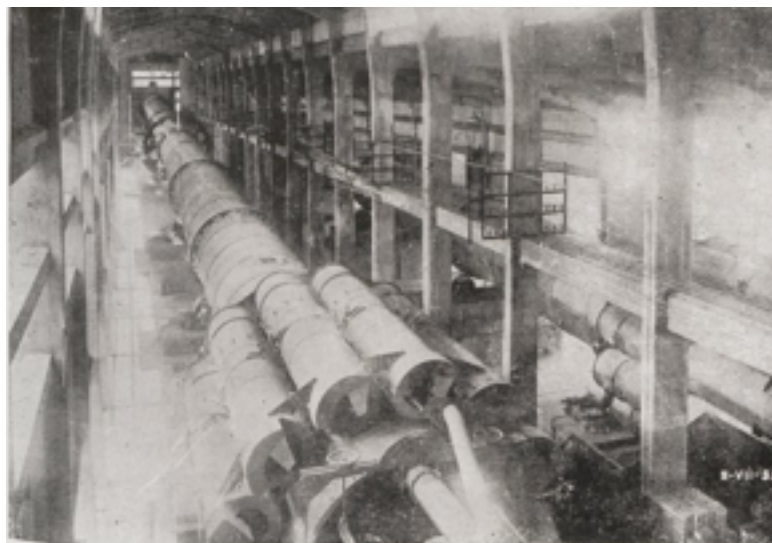
Fours rotatifs de 300 tonnes (longueur : 106 mètres)
