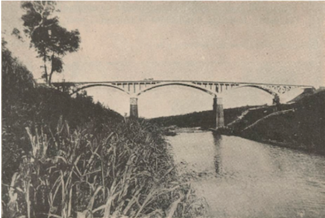
Pont en ciment armé sur la route coloniale n° 12.
