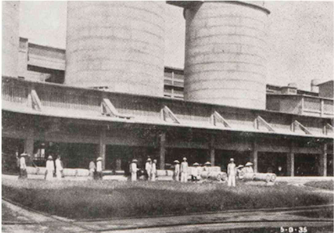
Silos à ciment et Hall d'emballage
