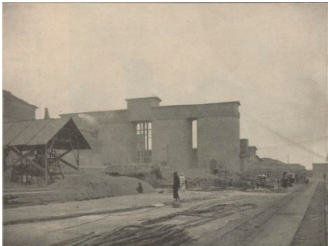
Silos de broyage de ciments.
