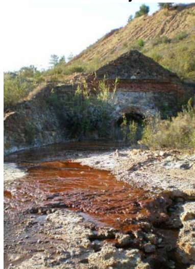
Figura 2: Portal Romano con Drenaje Ácido de Roca – España
