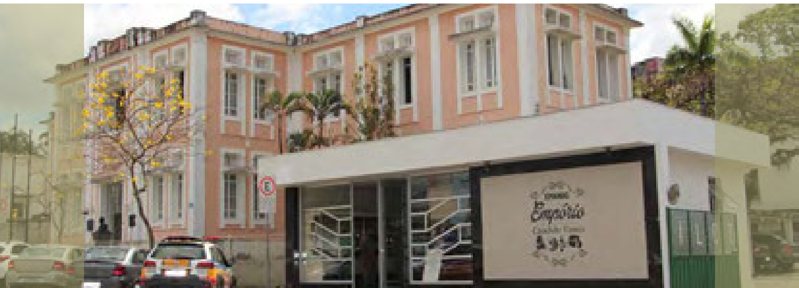
Prédio da EPAMIG ILCT - Instituto de Laticínios Cândido Tostes
