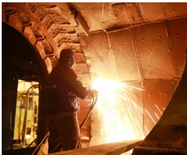
■ Демонтажа унутрашњости млина
