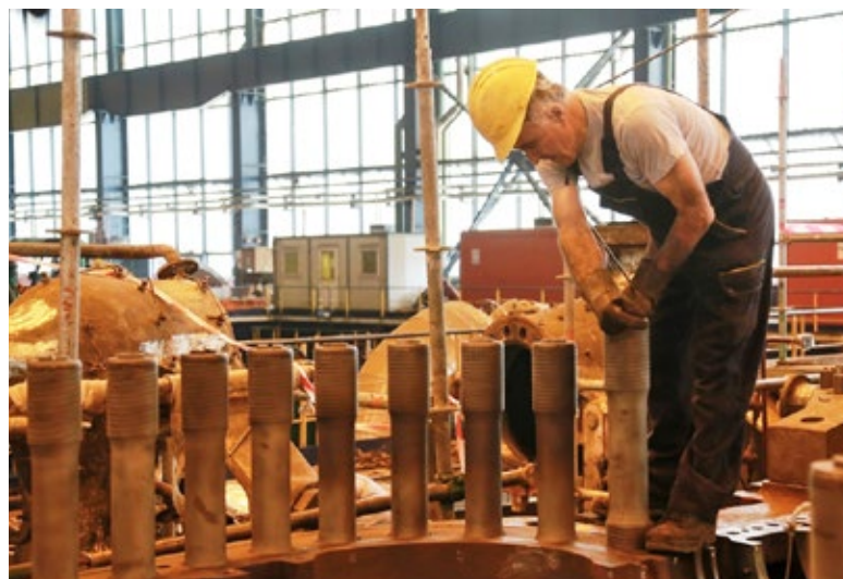
Провера навоја завртњева турбине
