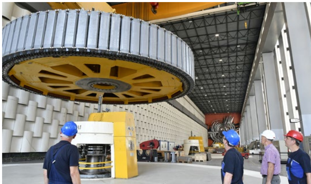
■ Монтажа задњег ротора у оквиру ревитализације ХЕ „Ђердап 1“
