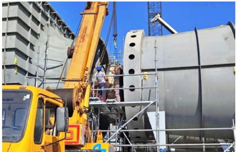
■ Монтажа и центрирање две лопатице
