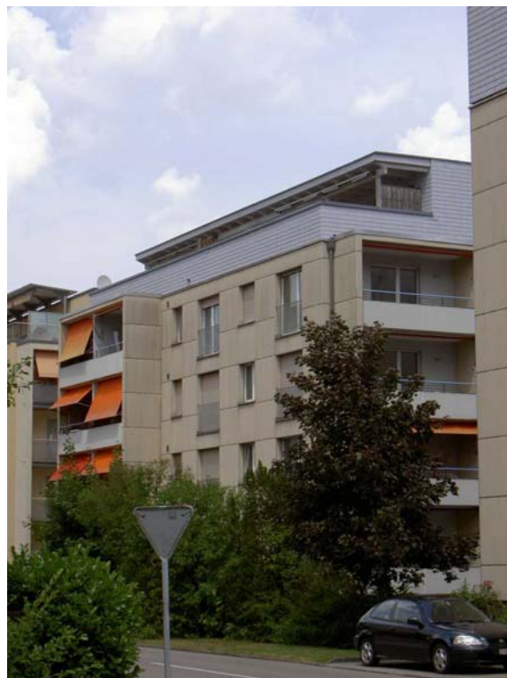
Abbildung 9: Nachträgliche Ergänzung eines Attika-Stockwerkes in einer Mehrfamilienhaussiedlung in Dulliken (eigene Aufnahme, aufgenommen im Juli 2006).
