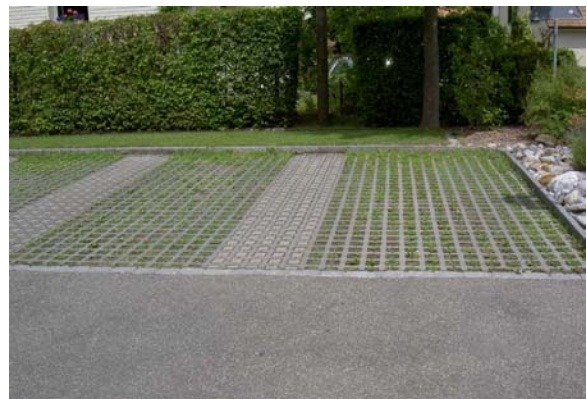
Abbildung 15: Positives Beispiel für die Belagswahl von Parkflächen (eigene Aufnahme, aufgenommen im Juli 2006).
