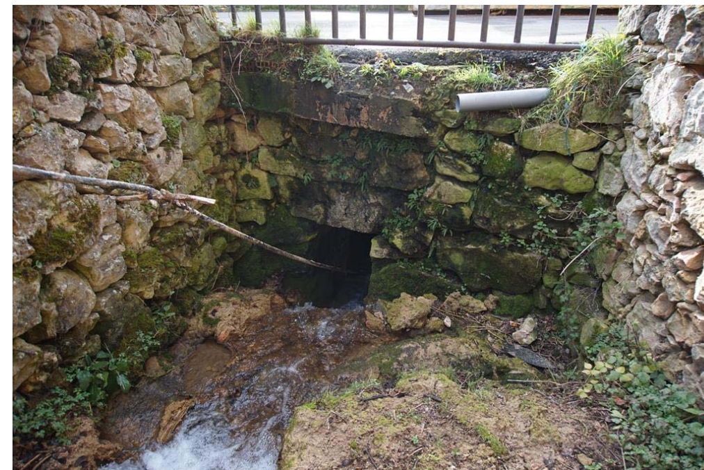
Fotografía-6: Obra de paso actual bajo la calle Afuera.
