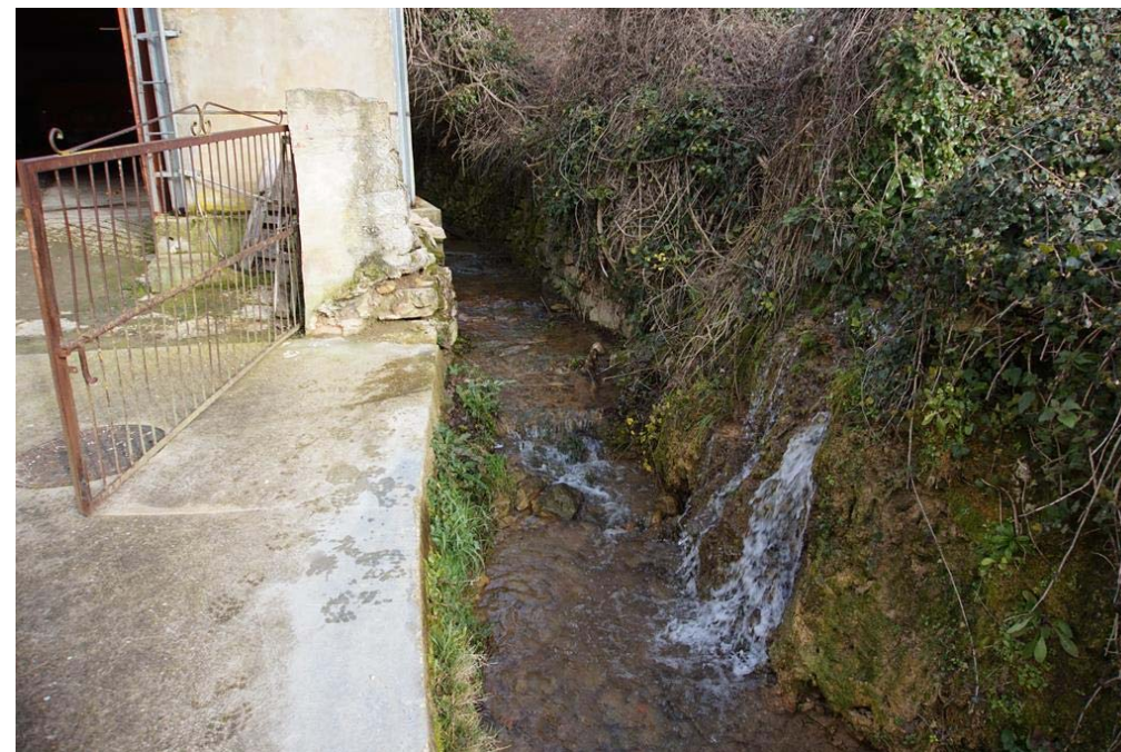
Fotografía-2: Inicio del tramo aguas arriba. Escorrentía en margen izquierda.
