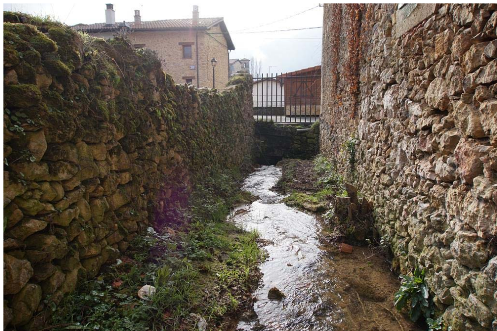
Fotografía-4: Final del tramo. Obra de paso sobre calle Afuera al fondo
