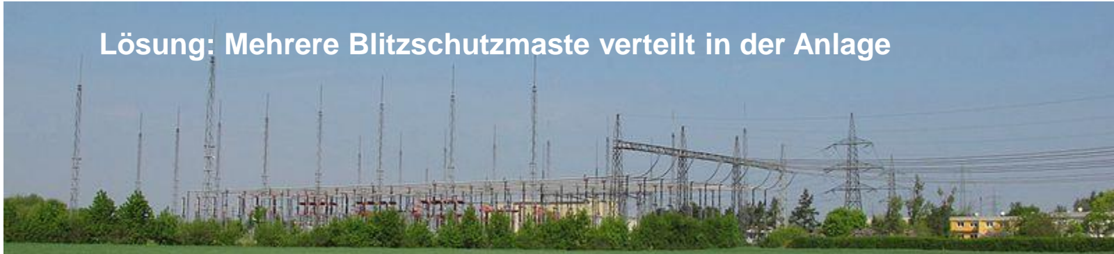
Blitzschutz im Unterwerk auf der Strecke Harbin-Dalian (Blitzschutz wurde vom chinesischen Design-Institut geplant) [97]
