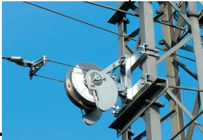
Nachspanneinrichtung mit Feder (Tensorix C+ - Pfisterer)
