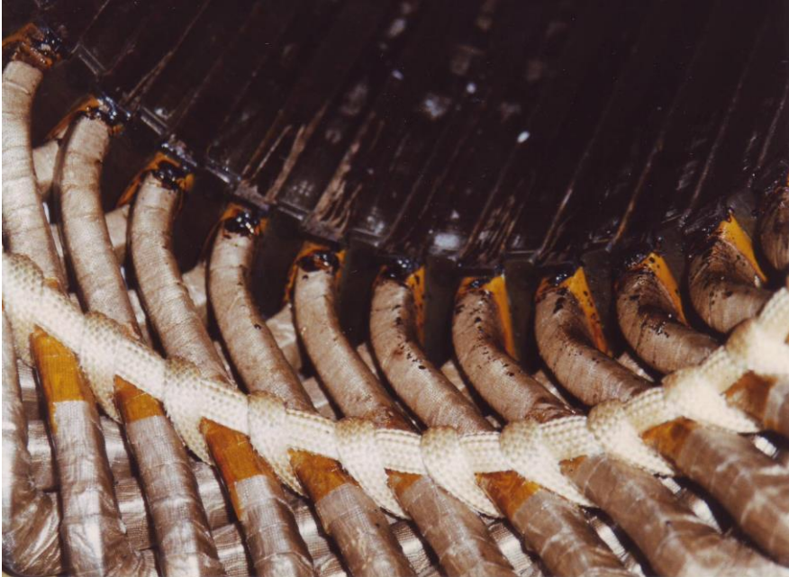
Bild 9.21 Austritt des Harzes im Bereich der Statornut Grund: Zu hohe Rotortemperatur [3]
