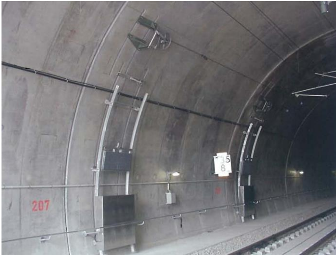
Nachspanneinrichtung mit Feder (Tensorix C+ - Pfisterer)
