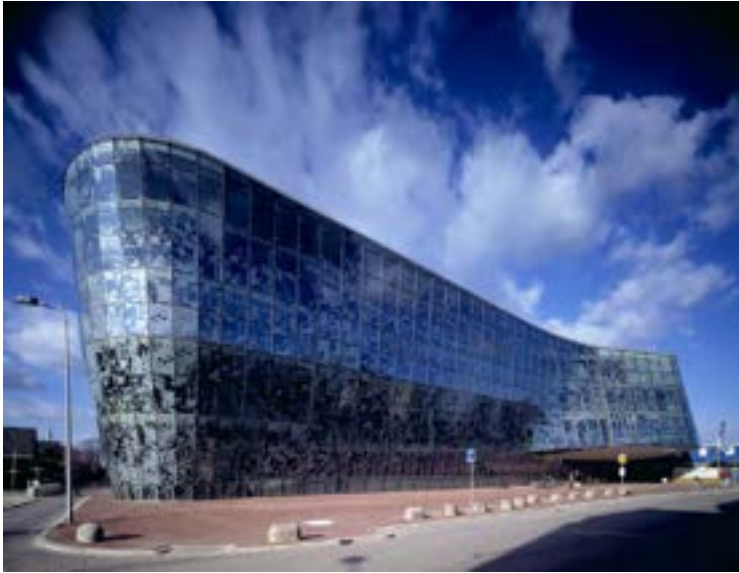
Fig. 14.10 Cold-warped IGU featured in City Hall project in Alphen aan den Rijn, Netherlands. Courtesy E. Van Egeraat, City Hall, Alphen aan den Rijn https://erickvanegeraat.com/project/city-hall-alphen-aan-den-rijn/ (Accessed 3 September 2022).
