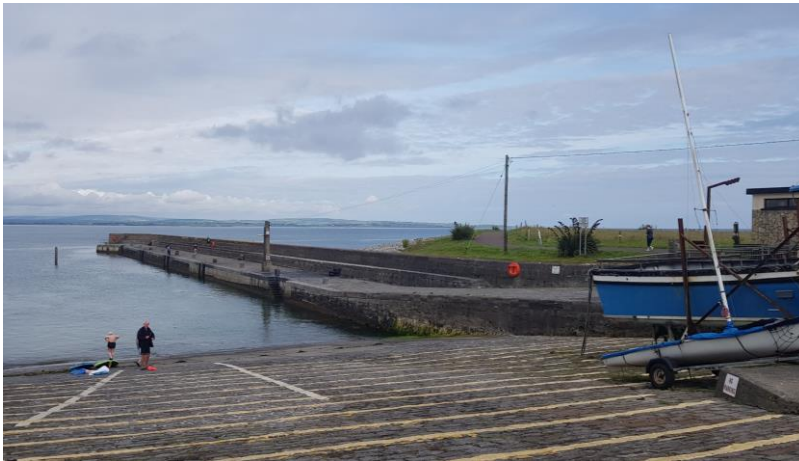
Plate 3.22 Inishcrone (Enniscrone) Pier.
