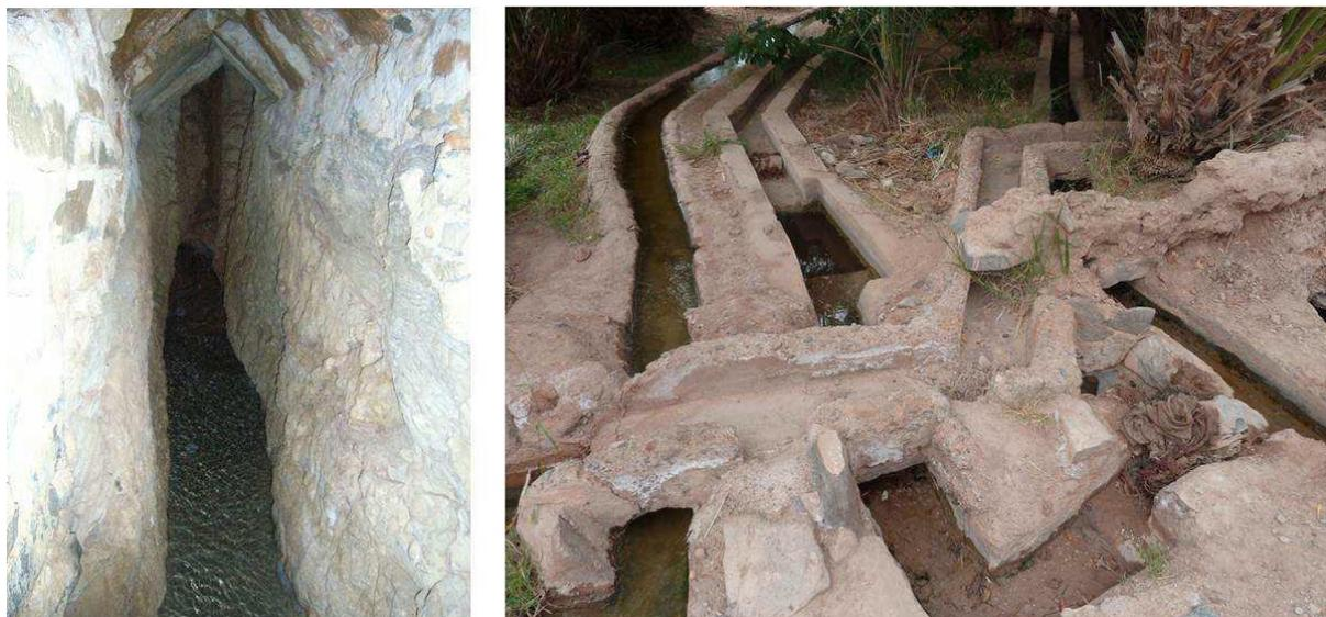
**Figure IV.3.1.1** : Foggara et seguia du réseau d'irrigation de Figuig (Source : Janty, 2011)
