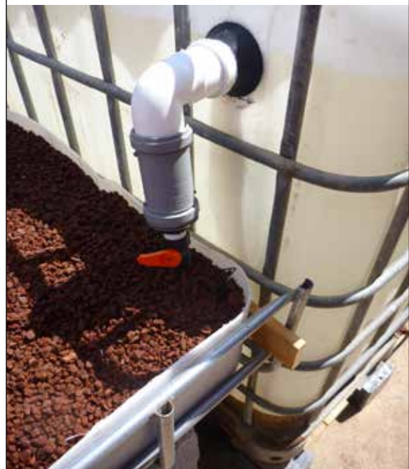
图4.32 用于深水养殖系统过滤的基质床单元
