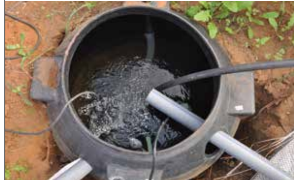
图4.47 集水槽埋在地下，通过重力收集水
