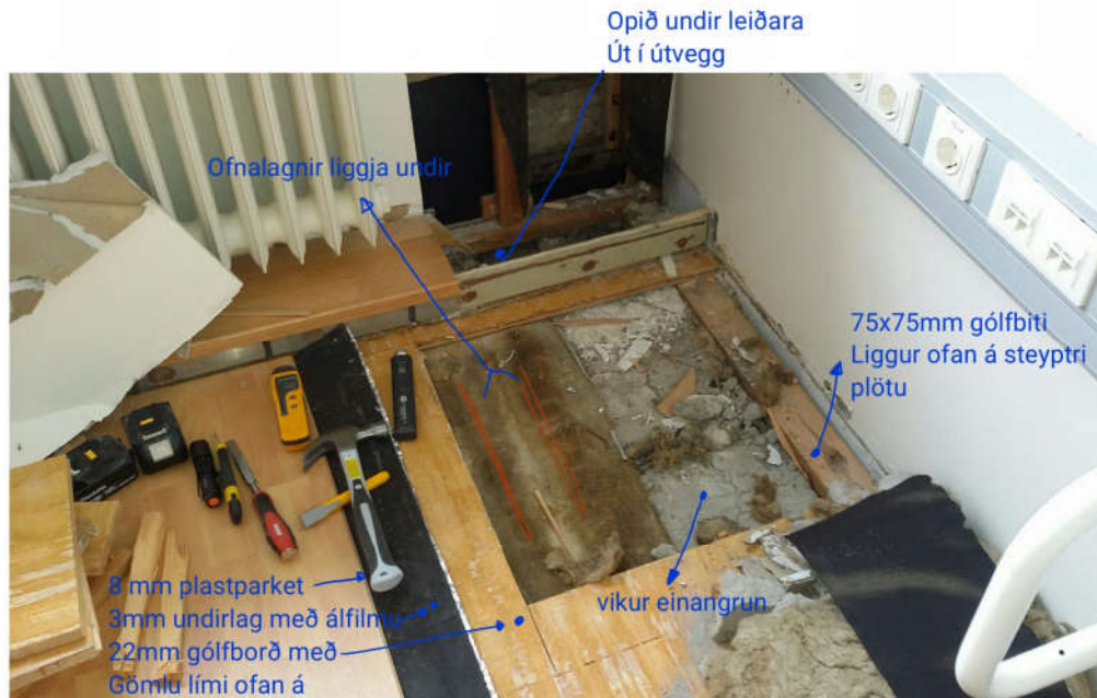
Mynd 14: Rými1. Skoðun. Opnun byggingahluta.
