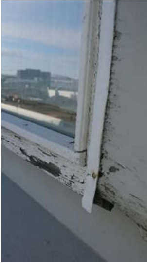
Mynd 31: Gluggi á 4. hæð séður utanfrá. Ástand orðið nokkuð lélegt.
