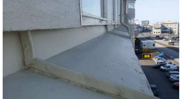
Mynd 32: Áfella á steiptum vegg. Nær uppað timburvegg og undir glugga.
