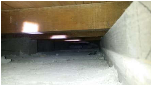
Mynd 25: Séð undir gólf meðfram útvegg. Opið er undir milli rýma á hæðinni.
