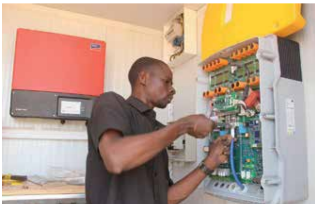
Moderne Solaranlagen erzeugen die nötige Energie. Die Wartung erfolgt durch angeleitete Kräfte vor Ort.
