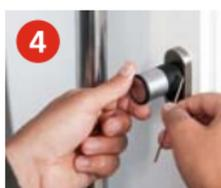
4 Befestigen des Drehknaufts mit dem mitgelieferten Inbusschlüssel.
