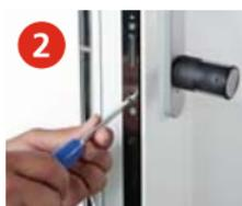
2 Den elektronischen TSE-Profil-Zylinder mit der Tür wie gewohnt verschrauben.
