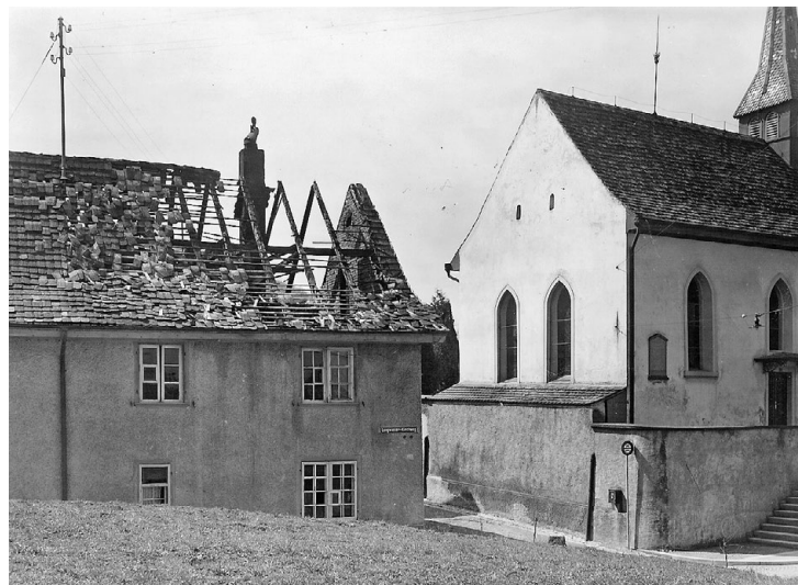
Das Haus am Kirchweg 2 wurde ebenfalls heftig getroffen.
