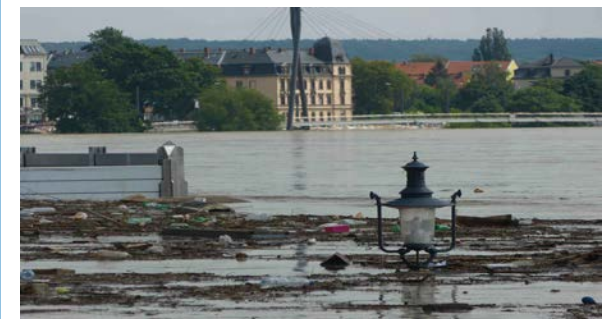
Böcklinstraße in Dresden beim Elbe-Hochwasser 2013
